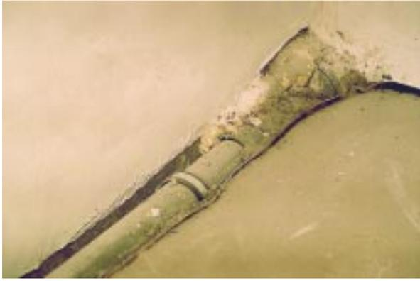
**Bild 6.2- 7:** Montage der Abwasserleitung direkt an der Außenwand verunmöglicht das Verputzen der Wand bis zur Rohdecke herab und führt zu erheblichen Luftundichtheiten.
