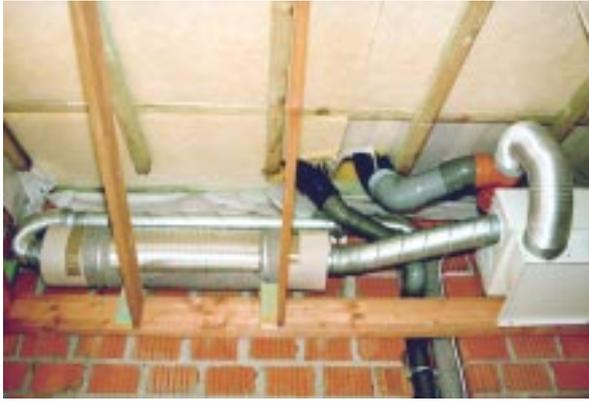
**Bild 6.5- 19:** Beengte Montage und Leitungsführung einer Abluftanlage mit undichter Durchdringung der luftdichtenden Folienebene.
