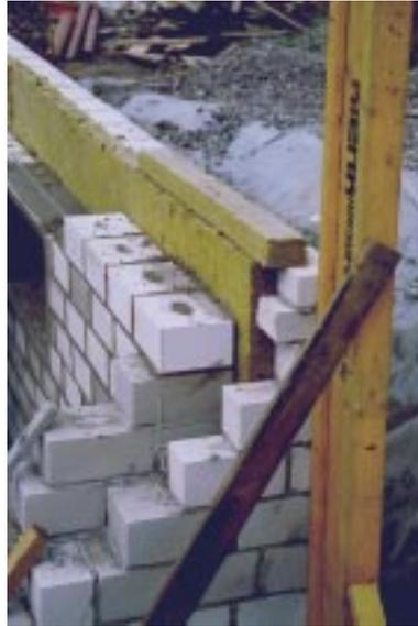
**Bild 5.2- 14:** Zweischalig ausgebildete Kellermauerkrone mit Steinwolle-Kerndämmung der oberen 30 cm.
