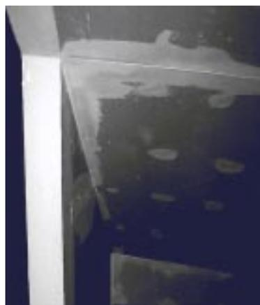
**Bild 4.6- 4:** Fertiggestellte untere Bekleidung einer unterseitig gedämmten Kellertreppe. (vgl. Bild 4.6-3).
