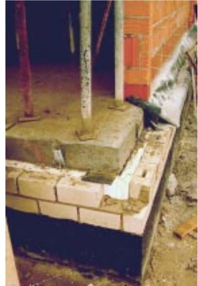
**Bild 5.2- 15:** Zweischalig ausgebildete Kellermauerkrone mit PS-Kerndämmung der oberen 20 cm.
