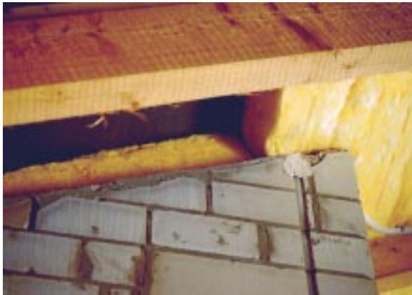
**Bild 5.7- 8:** Zwischensparrendämmung wird in voller Stärke über eine KS-Innenwand geführt.
