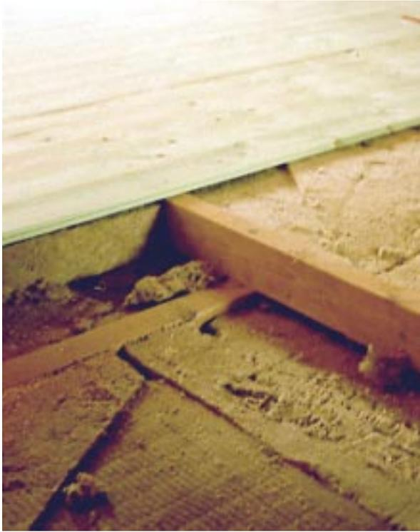
**Bild 4.10- 7:** Kehlbalkendecke mit oberseitig quer zu den Kehlbalken aufgedoppelter Dämmung und Laufebene aus Nut-und-Feder Massivholzdielen.
