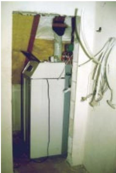
**Bild 6.5- 23:** Völlig beengte Platzverhältnisse in einem Mini-Heizraum erschweren alle Arbeiten an Installationen. Hier mußte z.B. die Dachfolie und innere Gipskarton-Bekleidung aufgeschnitten werden, um den Kessel überhaupt einbauen zu können. Die Wiederherstellung der Luftdichtung und Bekleidung oblag dem Bauherrn.
