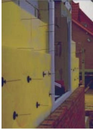
**Bild 5.5- 3:** Fenstermauernase mit verringerter Wärmebrücke durch 5 cm Hartschaum-Überdämmung.
