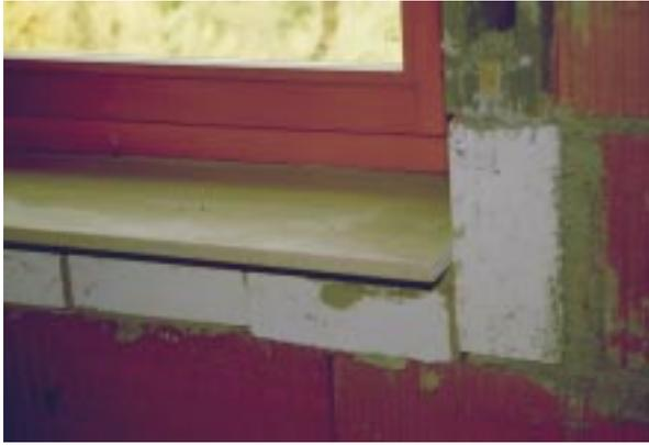
**Bild 5.5- 10:** Starke Wärmebrücke an der Brüstung durch auskragende Brüstungssteine aus KS als Unterfütterung der Steinfensterbank.
