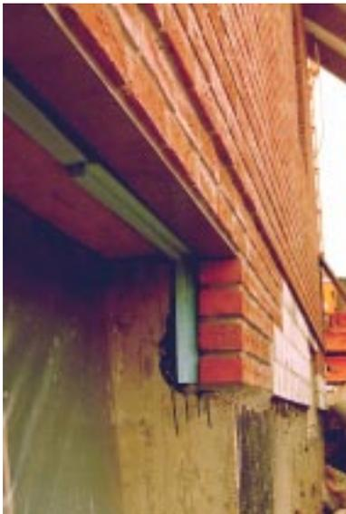
**Bild 5.2- 16:** Zweischalig ausgebildete Kellermauerkrone mit PS-Kerndämmung bis 60 cm unter Kellerdecke.
