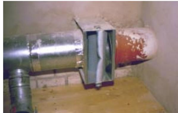
**Bild 8.2- 12:** Filterkasten in Zuluftleitung nahe dem Außenwandeinlaß auf dem Spitzboden.
