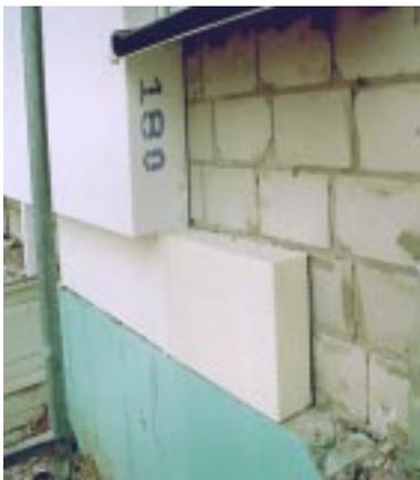
**Bild 4.3- 5:** außenseitige Dämmung der thermisch trennenden Kelleraußenwand bei einschaliger Bauweise mit Wärmedämmverbundsystem.
