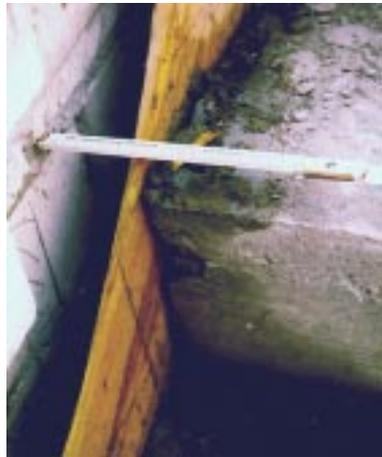
**Bild 5.3- 4:** 6 cm Fuge für nachträgliches Einbringen von Wärmedämmung zwischen warmer Kellertreppe und kalter (später treppenhausseitig gedämmter) Kellerwand.
