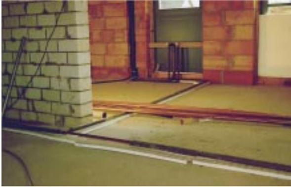
**Bild 4.2- 8:** Heizungs- und Warmwasserleitungen auf "kalter" EG-Decke richtig auf Dämmung verlegt
