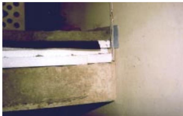
**Bild 4.2- 7:** Ausreichende Dämmung der Kellerdecke mit drei Lagen = 11 cm Dämmstoff.
