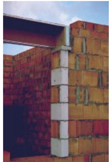
**Bild 5.5- 15:** Seitliche Zusatzdämmung eines Rolladenkastens.
