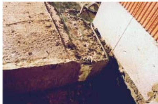
**Bild 5.4- 9:** Die vom Isokorb gewünschte thermische Trennung kann durch Beton-Überguß an der Oberseite und späteren Estrichüberguß wieder stark verringert werden.
