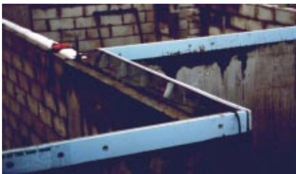
**Bild 5.2- 11:** Schalungshalter mit integrierter Stirnseitendämmung für Beton-Kellerdecke.
