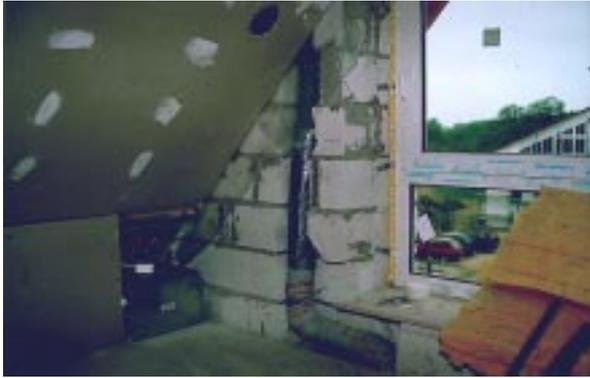
**Bild 8.2- 25:** Beengte Platzverhältnisse behindern die spätere Wartung.
