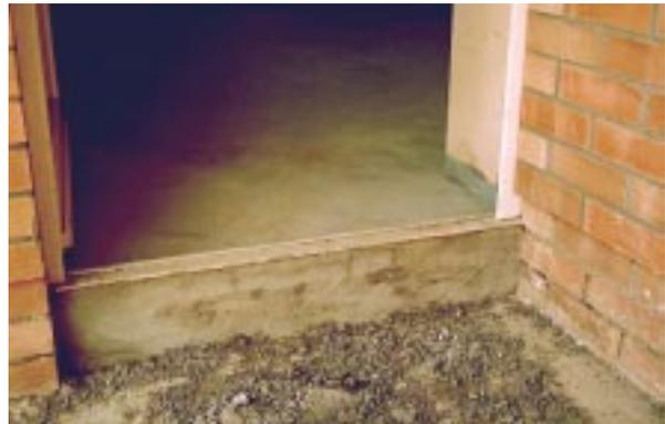
**Bild 5.5- 13:** Starke Wärmebrücke an der Türschwelle durch 6 cm Estrichüberdeckung des als thermische Trennung vorgesehenen Isomur-Steins unter der Tür.
