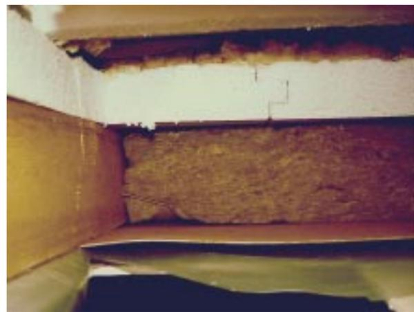
**Bild 4.9- 10:** Dach mit Aufsparrendämmung aus 10 cm Polystyrol WLG 035, 20 cm Zwischensparrendämmung WLG 040, Hartfaserplatte zum Abtragen der Dämmstofflasten und Dampfsperrfolie.
