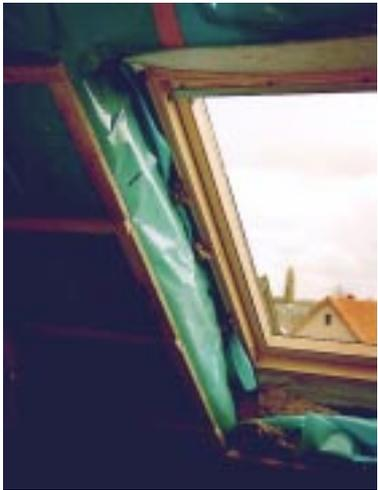
**Bild 4.13- 9:** fehlender Anschluß der Luftdichtungsebene an das Dachflächenfenster
