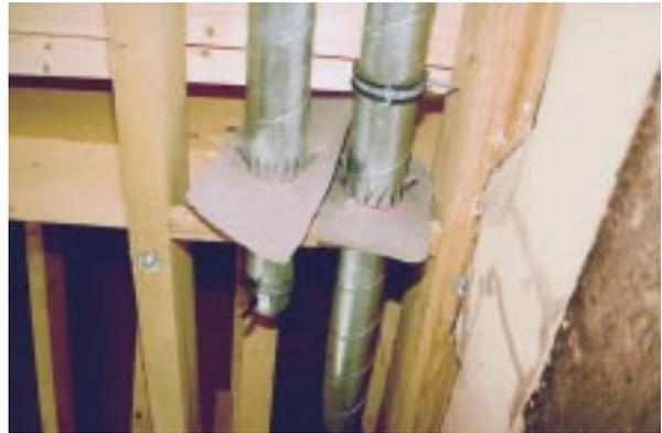
**Bild 6.5- 22:** Schon bei der Rohrmontage aufgesteckte Manschetten können die Luftdichtung erleichtern.
