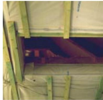
**Bild 6.4- 17:** Versuch eines luftdichtenden Übergangs zwischen UK Kehlbalkendecke und oberseitiger Dichtungsklappe.
