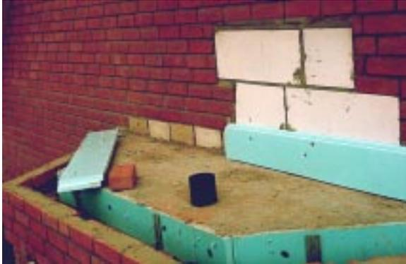
**Bild 4.11-4:** Die Erkerdecke wurde oberseitig gedämmt. Die Klinkerschicht sollte mit einer Reihe Porenbetonsteine auf die "warme" Erkerdeckenplatte aufgestellt werden. Die Handwerker verwendeten stattdessen Kalksandsteine, die die Wärmebrücke nicht verringerten.
