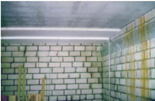
**Bild 4.2- 10:** 10 cm unterseitige Dämmung der Kellerdecke zusätzlich zu 7 cm oberseitiger Dämmung.
