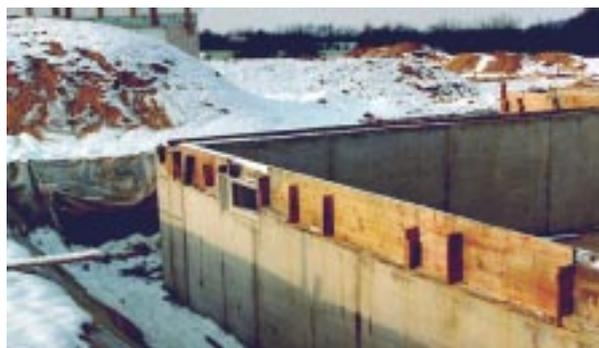
**Bild 5.2- 12:** Sonderschalung für zweischalige Beton-Kellermauerkrone mit Kerndämmung.
