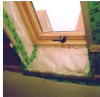
**Bild 6.4- 20:** Relativ ordentlicher Versuch einer luftdichtenden Abklebung zwischen PE-Folien und Holzrahmen eines Dachflächenfensters.
