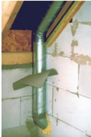
**Bild 6.5- 15:** Abdichtungs-Manchette auf Abluftleitung schon vom Rohrbauer aufgesteckt. Rohrverlegung in Raumecke behindert jedoch Innenputz und Folienanschluß an Wände.
