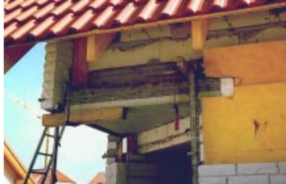
**Bild 4.11-5:** Die Decke über Außenluft blieb ohne unterseitige Dämmung. Der Raum darüber ist Badezimmer. Der Klinker ist ohne thermische Trennung an dem Bauteil befestigt. Das Gebäude wurde während der Bauphase nicht betreut.
