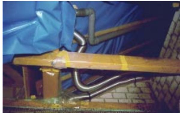
**Bild 8.2- 26:** Unkoordinierte Rohrverlegung im Dach erschwert spätere Luftdichtung.
