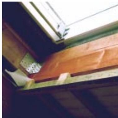
**Bild 6.4- 19:** Völlig fehlender luftdichtender Folienanschluß an einem Dachflächenfenster.
