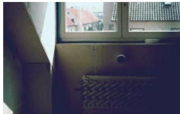
**Bild 8.2- 8:** Zuluftventil in einem Dachraum in der Gauben-Vorderwand.
