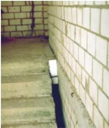
**Bild 5.3- 8:** Wärmebrückenarme Verbindung zwischen kaltem Treppenpodest und warmer Geschoßdecke durch Treppenpodest mit Isokorb.
