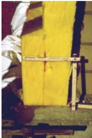
**Bild 4.4- 17:** 18 cm Kerndämmung aus Mineralwolle im Eingangsbereich eines Mehrfamilienhauses.
