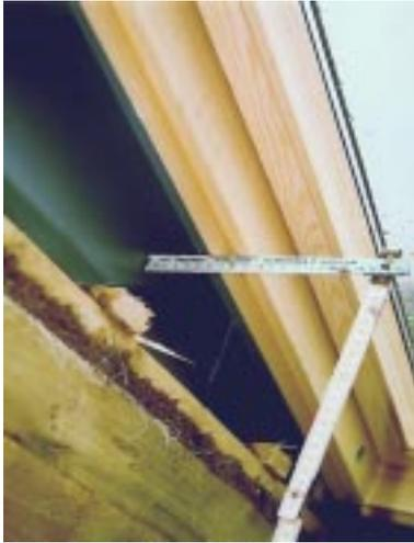
**Bild 4.13- 6:** Dachflächenfenster mit zusätzlichem Metall-Aufkeilrahmen, nur 5 cm Dämmung möglich.
