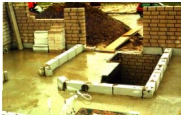
**Bild 5.2- 10:** Thermische Trennung der auf einer kalten Kellerdecke aufstehenden EG-Mauern durch unterste Steinreihe aus wenig wärmeleitendem Porenbeton ( $\lambda = 0,12 \text{ W/mK}$ ).
