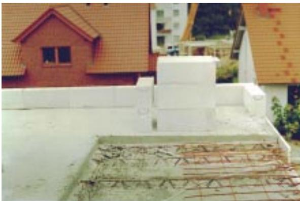
**Bild 5.4- 8:** Betonaussparung für wegen verspäteter Anlieferung erst nachträglich einsetzbar gewesenen Isokorb.
