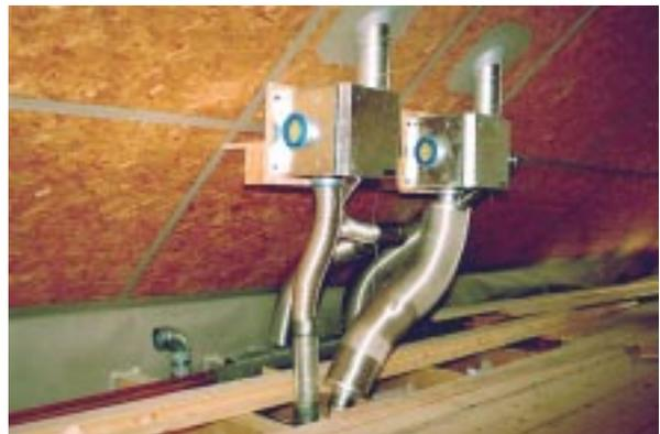
**Bild 6.5- 18:** Rohrdurchführung durch die luftdichtende Holzwerkstoffplatte im Schrägdach mit glattwandigen Rohren und Baupappe-Abklebung.
