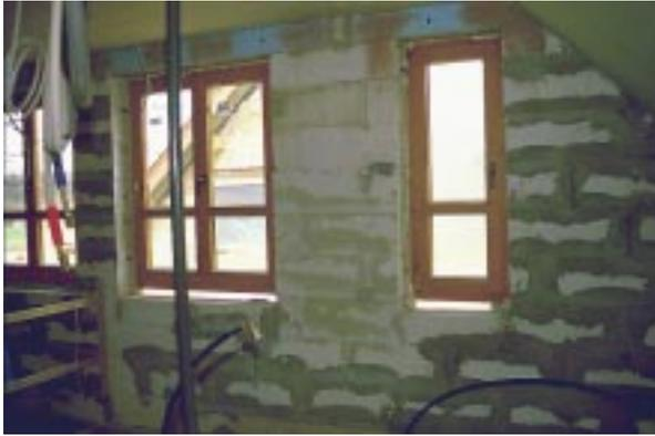
**Bild 6.2- 1:** Nicht luftdichte, weil nur fugenverspachtelte Porenbeton-Außenwände mit späterer innerer Bekleidung aus Gipskartonplatten.
