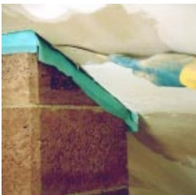
**Bild 6.3- 9:** Häufiger Irrtum. Überstehende Folienränder werden abgeschnitten statt eingeputzt.
