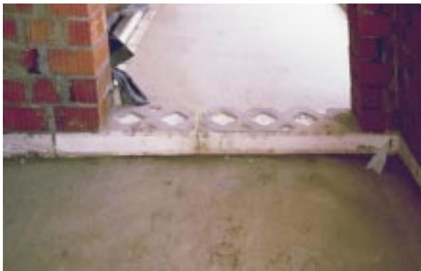
**Bild 5.2- 9:** Thermische Trennung der auf einer kalten Kellerdecke aufstehenden Innenmauerschale durch ein Spezialbauteil (Schöck "Isomur").
