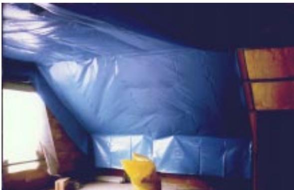
**Bild 6.3- 1:** Luftdichtung aus großflächiger Polyethylenfolie.
