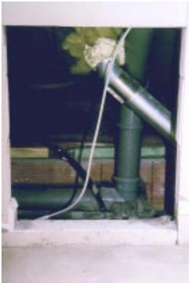
**Bild 6.5- 14:** Pseudo-"Abdichtung" zwischen Lüftungsrohr und Folie mittels Ortschaum.
