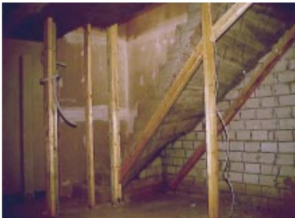
**Bild 4.6- 3:** Holzkonstruktion für unterseitige Dämmung einer thermisch trennenden Kellertreppe. Der asymmetrische Hohlraum wurde mit Mineralwolle-Reststücken verfüllt. (vgl. Bild 4-6-4).
