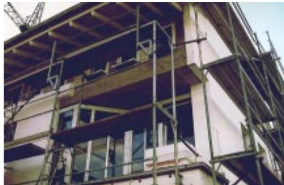
**Bild 4.11-7:** Die Decke über Außenluft wurde unterseitig mit der Außenwanddämmung (18 cm WLG 040) versehen. Zusammen mit den 5 cm Unterstrichdämmung erreicht dies noch nicht die Vorgabe. Das Gebäude war in der Ausführungsphase nicht betreut.
