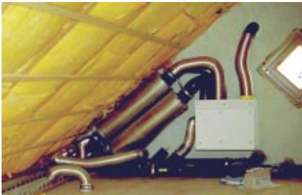
**Bild 8.2- 21:** Lüftungsanlage mit Abluftwärme-rück-gewinnung in einem ZFH.
