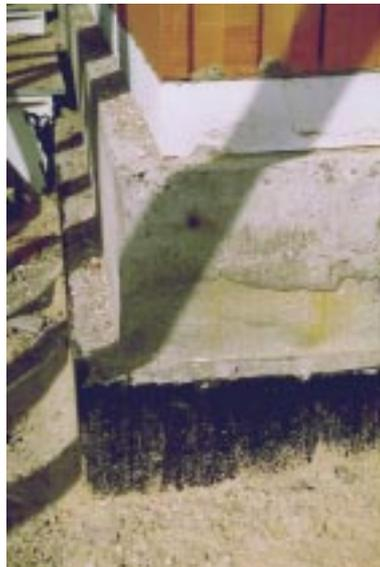
**Bild 5.2- 17:** Abgetreppte Kellermauerkrone für abgestufte Außendämmung mit wärmedämmendem Mauergrundstein unter EG-AW.
