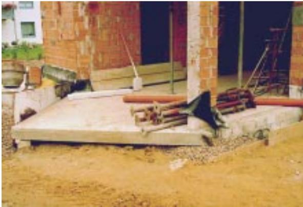
**Bild 5.4- 12:** Luftunterspülte Erkerbodenplatte.
