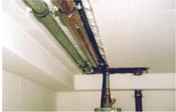
**Bild 4.2- 9:** 18 cm unterseitige Dämmung der Kellerdecke mit eingeschnittenen Rohrkanälen und Zusatzdämmung der oberen 36 cm der Kellermauerkrone.
