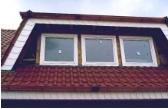
**Bild 4.12- 6:** Wärmebrücken an den Anschlüssen der einzelnen Fenster an die von innen nach außen durchlaufenden Stützen der Gaubenvorderwand. Große Holzanteile statt eines durchgehenden Fensterbandes.
