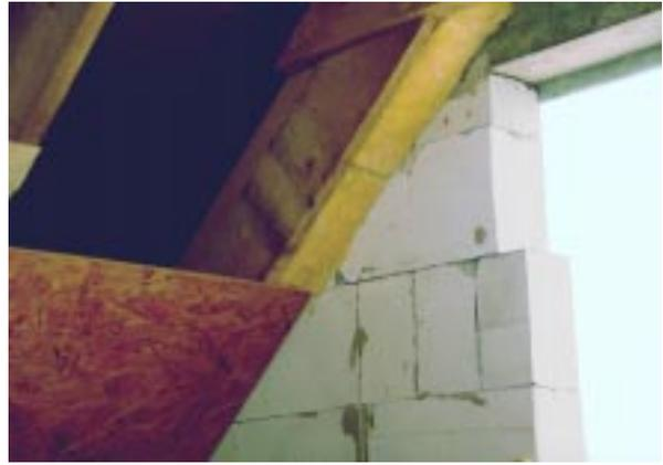
**Bild 5.7- 7:** Dämmung zwischen Sparren und Giebelmauer konnte montiert werden.
