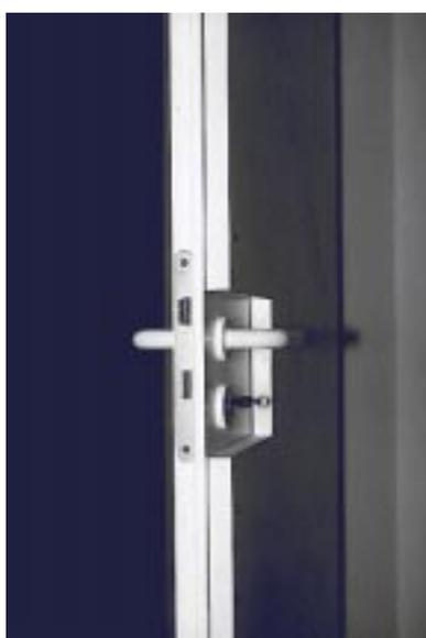
**Bild 4.7- 6:** Tür zwischen kaltem Keller und beheiztem Kellerflur im EFH mit einseitiger Zusatzdämmung. Die Tür wird sich vermutlich verwinden, so daß die Lippendichtungen nicht mehr hinreichend funktionieren.
