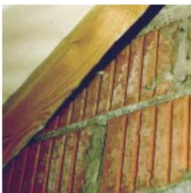
**Bild 6.3- 7:** Fehlerhafter Anschluß zwischen PE-Folie und Mauerwerk. Das vorkomprimierte Dichtband kann die starken Profilierungen der unverputzten Wand nicht ausfüllen.
