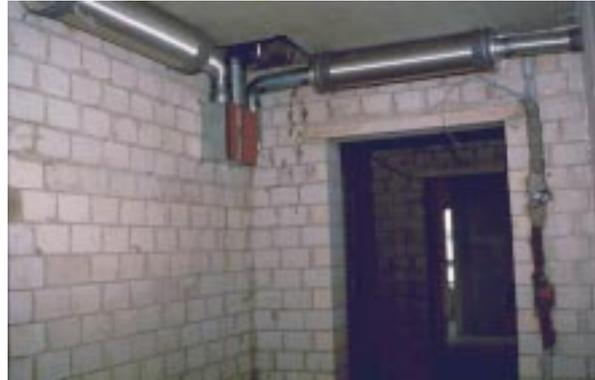
**Bild 8.2- 18:** Wohnungsweise Abluftventilatoren in einem MFH innerhalb der Wohnungen.
