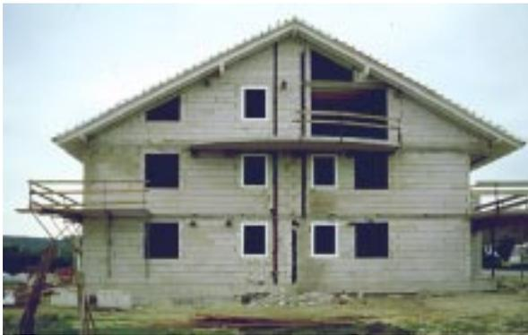
**Bild 4.4- 6:** Schwächung von 17,5er-Mauerwerk durch mehrere haushohe Schlitze.
