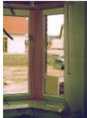
**Bild 6.4-1 1:** Immer noch ungelöste Luftdichtung des Erker-Eckpfostens, hier für Luftdichte-Messung provisorisch abgeklebt.
