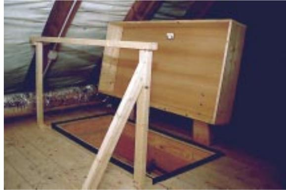
**Bild 4.14- 3:** Zusätzliche Luftdichtung durch Klappdeckel noch ohne Zusatzdämmung.
