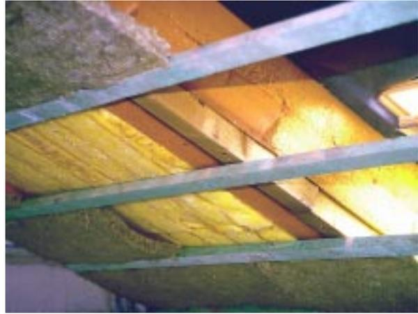
**Bild 4.9- 14:** NEH-Dachaufbau mit Dämmschichten zwischen unterseitig längs aufgedoppelten Sparren und zusätzlich zwischen unterseitiger Querlattung.
