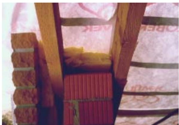
**Bild 5.7- 5:** Giebelmauer mit ca. 8 cm Mineralwolle-Dämmung belegt, Dämmung zwischen Wand und Sparren wegen zu geringen Abstandes nicht möglich.
