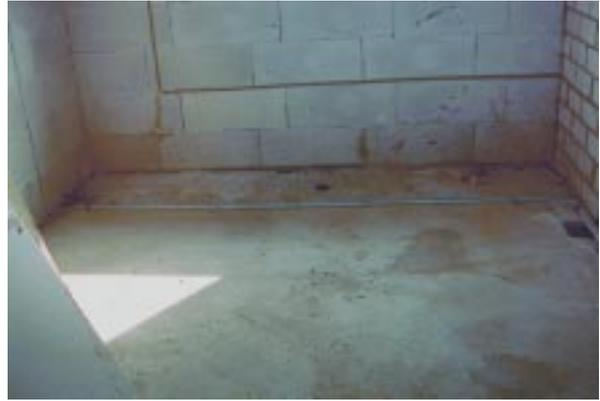
**Bild 6.5- 5:** Strom-Hüllrohr mit Abstand zur Außenwand ermöglicht vollflächiges Verputzen.
