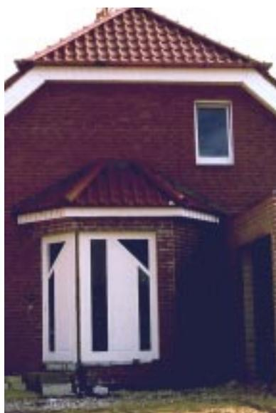
**Bild 4.7- 5:** Hauseingangselement mit nur geringen Glasanteilen, das die Planer in der Energiebilanz dennoch zu den Fenstern zählten.
