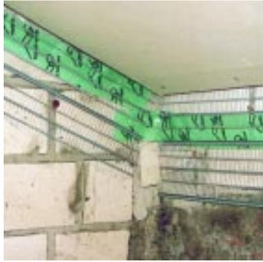
**Bild 6.3- 4:** Anschluß von Folien an Mauerwerk durch provisorisches Ankleben, Überdecken mit Streckmetall und späteres Einputzen.
