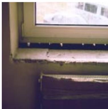
**Bild 6.4- 4:** Unklare Luftdichtung und fehlende Wärmedämmung unterhalb des Fensterrahmens an einer gemauerten Fensterbrüstung noch nach dem inneren Verputzen. Soll hier die nur Fensterbank "dichten und dämmen" ?
