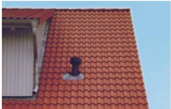
**Bild 8.2- 28:** Gut funktionierender Fortluft-Dachdurchlaß aus Lüftungs-Sortiment.
