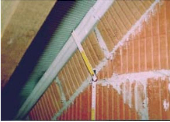
**Bild 5.7- 6:** Innenansicht von Detail 5.7-4, Sparren liegt mit hinreichendem Abstand zur Giebelmauer.
