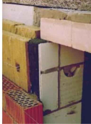
**Bild 5.5- 6:** Fenstermauernase mit starker Wärmebrücke aus KS-Steinreihe ohne Dämmung.
