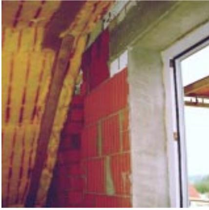
**Bild 5.6- 7:** Giebelwand des unbeheizten Spitzbodens mit Porenbetonstreifen in der Ebene der Kehlbalckendecke von OG-Außenwand abgetrennt (Innenansicht zu Bild 5.6-6).
