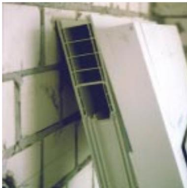
**Bild 6.4- 13:** Kunststoff-Verlängerungsprofile für bodentiefe Fenster mit nicht luftdichter Steckverbindung.
