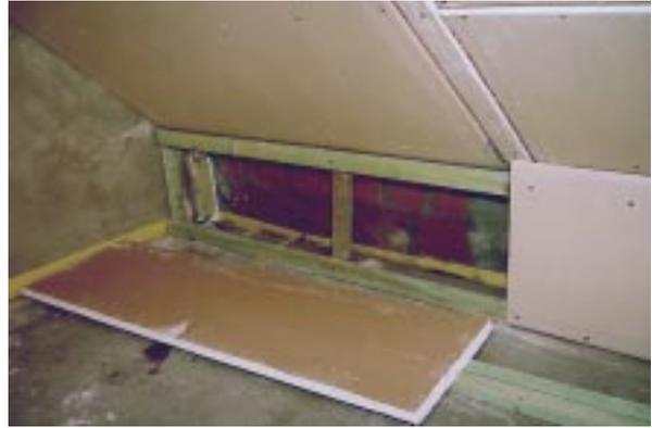
**Bild 6.2- 2:** Nicht luftdichte, weil unverputzte Drempelmauer unter der Fußpfette. Die Leichtbau-Abseitenwand ist wegen der vielen durchdringenden Installationen ebenfalls nicht luftdicht.
