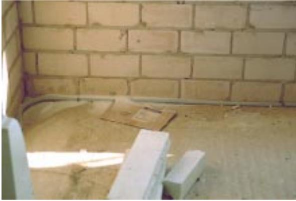
**Bild 6.5- 4:** Strom-Hüllrohr direkt an Außenwand behindert vollflächiges Verputzen.
