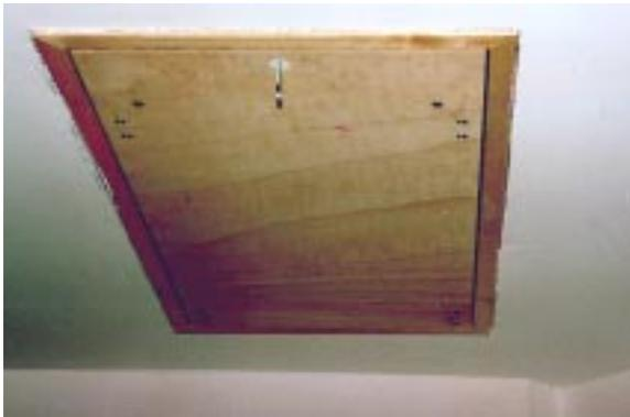
**Bild 4.14- 6:** Optisches Foto einer Bodenluke mit ca 20 cm Zusatzdämmung und k-Wert um 0,18 W/m<sup>2</sup>K
