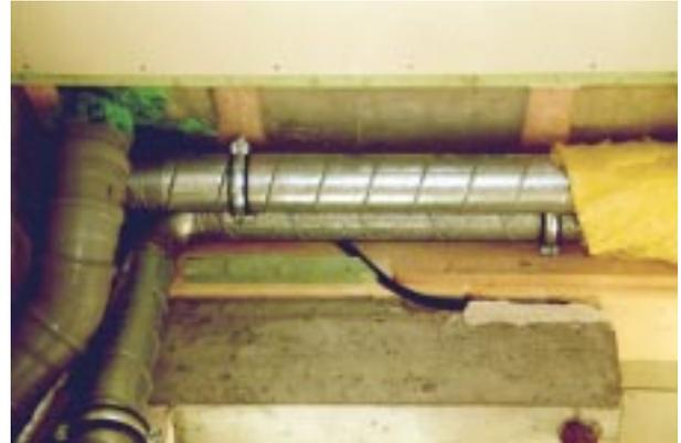
**Bild 6.5- 20:** Direkt benachbarte Durchdringungen mehrerer Leitungen erschweren die Anarbeitung der Luftdichtung.
