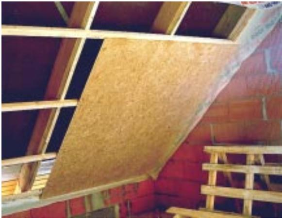
**Bild 4.9- 15:** NEH-Dach mit Unterdach aus bitumierter Holzweichfaserplatte, unterseitiger Längs- und Queraufdoppelung der Sparren und innerer Luftdichtung aus verklebten OSB-Platten. Als Dämmstoff wurden hier später Zelluloseflocken eingeblasen.
