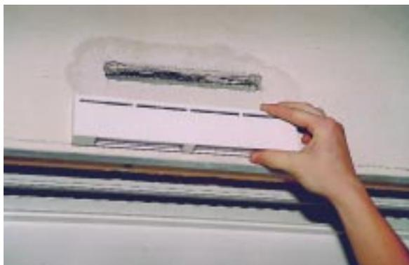
**Bild 8.2- 7:** Feuchtereguliertes Zuluftventil am Innendeckel eines Rolladenkastens.
