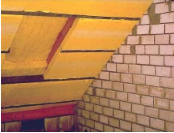
**Bild 4.9- 13:** NEH-Dachaufbau mit 20 cm Zwischensparrendämmung und unterseitiger Zusatzdämmung zwischen einer 4 x 10 cm Querlattung.
