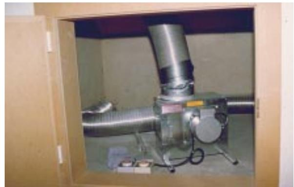
**Bild 8.2- 14:** Zentraler Abluftventilator in der Abseite im OG eines EFH (Exhausto).
