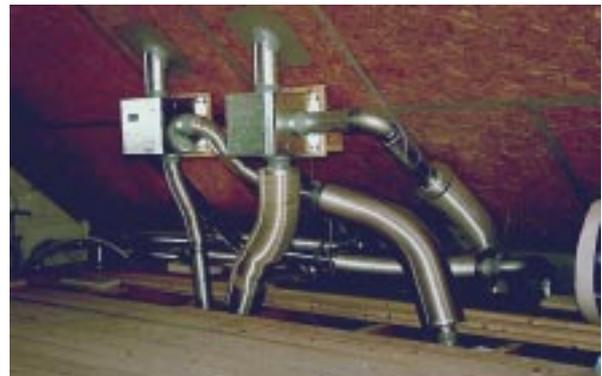
**Bild 8.2- 16:** Körperschall-intensive Aufhängung von Abluftventilatoren direkt am Schrägdach.
