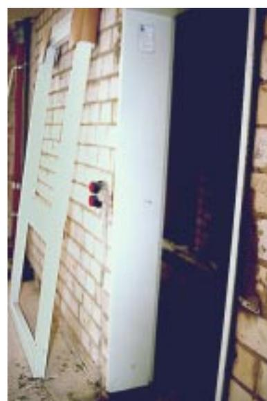
**Bild 4.7- 7:** eine von 16 falsch gelieferten Zargen zwischen Wohnungen und unbeheiztem Treppenhaus in einem MFH. Die Zarge umfaßte nur die 24er Wand, nicht jedoch die 12 cm Dämmung der thermisch trennenden Wand.
