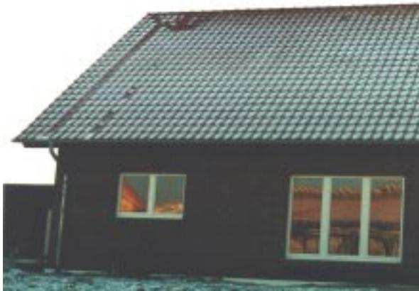
**Bild 5.7- 2:** Schneeabtauung an Giebelmauer wegen fehlender Wärmebrückenvermeidung.
