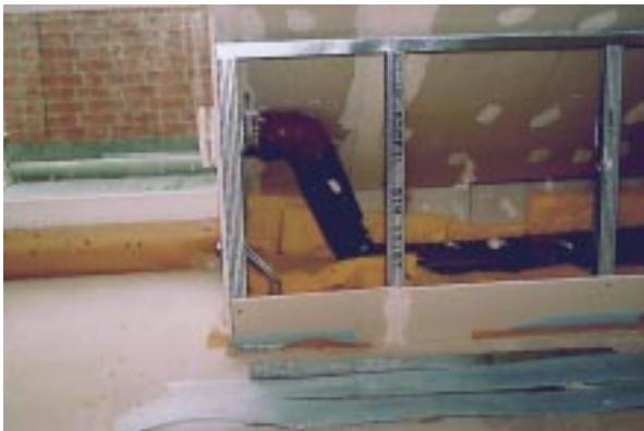
**Bild 6.2- 3:** Nicht luftdichte, weil unverputzte Mauer unter der Fußpfette im Drempelbereich. Als Ersatz wurde die Luftdichtungsfolie des Schrägdaches bis auf die Rohdecke herabgeführt.
