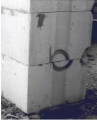
**Bild 4.5- 8:** einschalige Trennwand zwischen Keller und Flur im EFH aus 36,5 cm Porenbeton.
