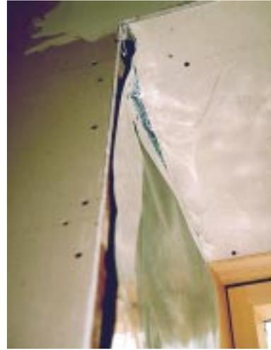
**Bild 4.13- 8:** Wärmedämmzarge ausgetauscht gegen selbstgebauten Schichtholz-Rahmen. Die geplante Wärmebrückenvermeidung wurde verfehlt.
