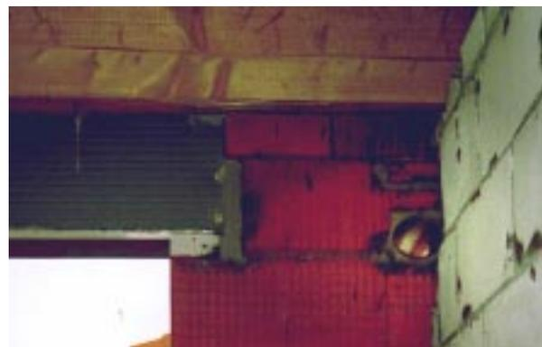
**Bild 8.2- 6:** Zuluft-Durchlaß zu nahe an Innenwand plaziert.
