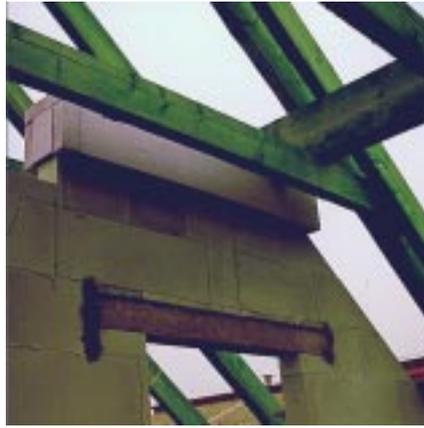
**Bild 5.6- 8:** Dachgeschoß-Innenwand ragt mit Betonaufleger der Mittelpfette in kalten Luftraum des Spitzbodens. Allseitige Dämmung verringert die Wärmebrücke.
