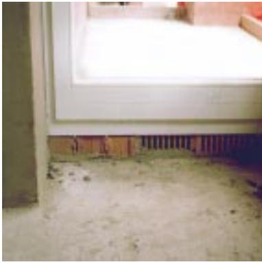
**Bild 6.4- 6:** Luftundichte Unterfangung einer Terrassentür.
