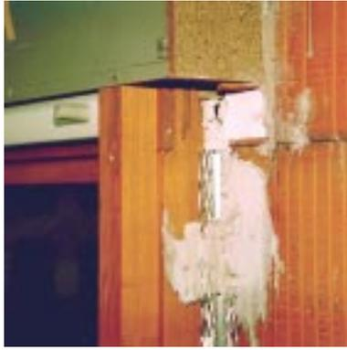
**Bild 6.4- 7:** Unzureichend stabile Putz-Verbindung zwischen Innenmauer und weit vorgebautem Fenster von außen (vgl. Bild 6.4-8).
