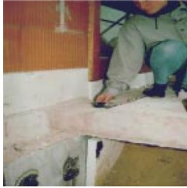
**Bild 4.3- 9:** nicht genügende außen-seitige Dämmung der thermisch trennenden Kelleraußenwand aus zu diesem Zweck ungeeigneten Polystyrolplatten. Die innenseitige Dämmung wurde nur nach Anmahnung realisiert.
