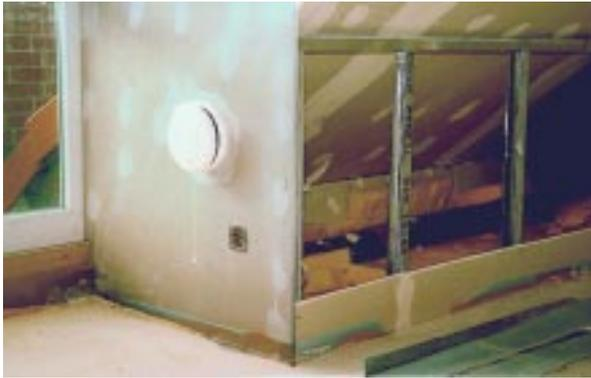
**Bild 8.2- 9:** Zuluftventil in einem Dachraum durch die Gauben-Seitenwand.
