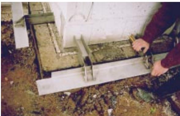
**Bild 4.4- 19:** Edelstahl-Winkelschiene für das Klinkerauflager. Die Spezialanfertigung für die Verbreiterung des zu schmalen Mauervorsprungs wird in die Innenmauerschale eingestemmt.
