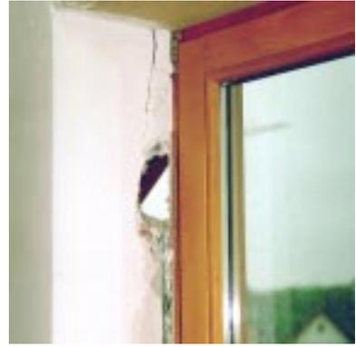
**Bild 6.4- 8:** Aufgebrochene Putz-Verbindung zwischen Innenmauer und weit vorgebautem Fenster von innen (vgl. Bild 6.4-7).
