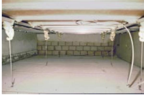
**Bild 6.2- 8:** Unverputzte oberste 80 cm einer Außenwand im Bereich einer später abgehängten Decke bewirken gravierende Luftundichtheiten (Foto nicht aus dem Untersuchungsgebiet).
