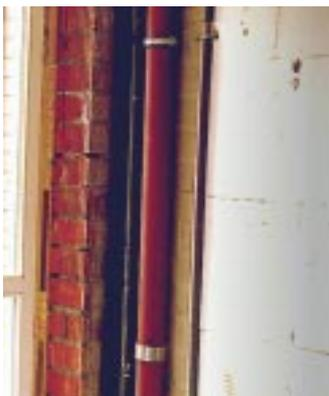
**Bild 4.5- 14:** In der Dämmebene einer Trennwand zwischen Treppenhaus und Wohnung im MFH verlegte Leitungen mit starker Wärmebrückenwirkung.
