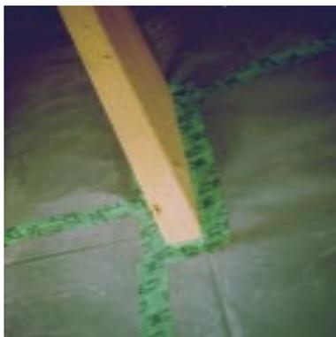
**Bild 6.3- 10:** Anschluß eines durchdringenden Balkens mit Klebebändern.
