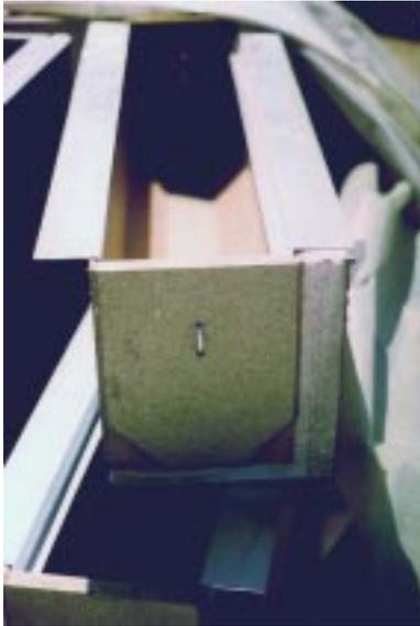
**Bild 5.5- 17:** Üblicher Rolladenkasten mit nur innenseitig ausreichender Dämmung.
