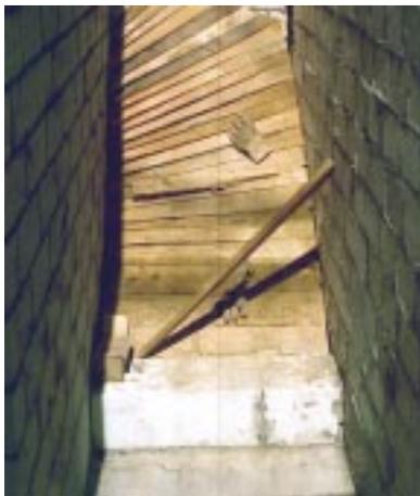
**Bild 5.3- 3:** Wärmedämmender Porenbeton-Stein als Auflager zwischen warmem Kellertreppenlauf und kalter Sohlplatte.
