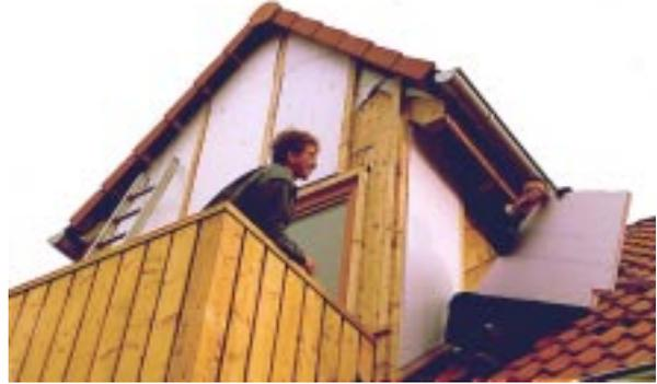
**Bild 4.12- 7:** Äußere Zusatzdämmung einer Gaube mit Hartschaumplatten auf einer Holzschalung. Eine Tauwasserberechnung für diesen improvisierten Wandaufbau wurde nicht erstellt.
