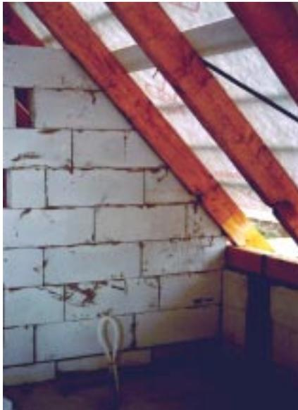
**Bild 5.7- 10:** Innenwand wird bis unmittelbar gegen den Sparren gemauert, Holz als einzige Dämmung zwischen Innen und Außen.
