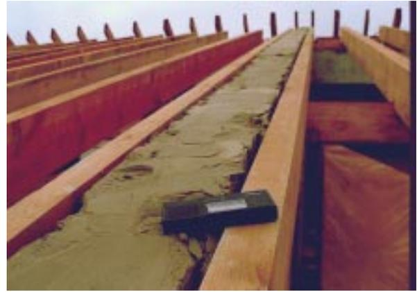
**Bild 5.7- 9:** Innenwand reicht bis in den Luftraum und kann nicht überdämmt werden, beide Sparren liegen zu nah neben der Wand.
