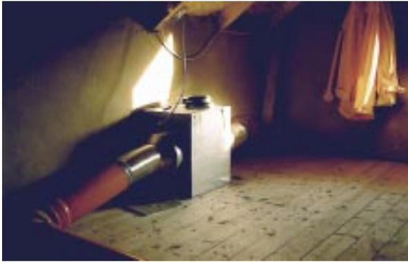
**Bild 8.2- 17:** Weit überdimensionierter Abluftventilator in EFH ohne Fortluftschalldämpfer.
