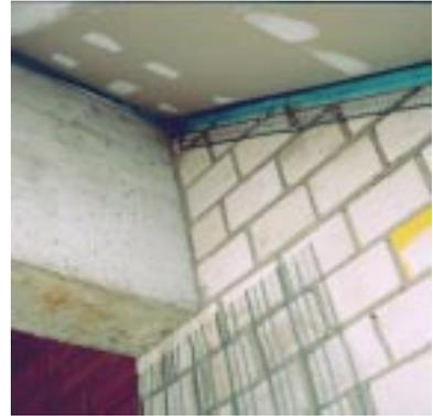
**Bild 6.3- 5:** Folienanschluß durch Einputzen unter Streckmetall funktioniert nicht am Betonträger. Das Streckmetall steht unbenutzt herum.
