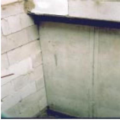
**Bild 4.3- 8:** Mauernische für innen-seitige Dämmung der thermisch trennenden Kelleraußenwand im Bereich des Kellertreppenraumes bei zweischaliger Bauweise. Eine Stahlwinkelschine trägt als Sturz die EG-Innenwand.
