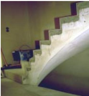
**Bild 4.1-8:** Höhere Bodenaufbauten auf Sohlplatten müssen bei Treppen- und Türstürzen beachtet werden. Werden falsche Höhenlinien zu spät bemerkt, können auf Treppen enorme Ausgleichsestriche nötig werden.
