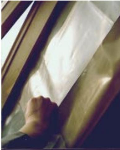
**Bild 4.13- 10:** Dachflächenfenster mit werkseitig vorbereiteter Montageerleichterung für das Erreichen der Luftdichtheit. Diese besteht aus einer an den Blendrahmen luftdicht angearbeiteten, umlaufenden Folienschürze, die mit der sonstigen Luftdichtungsebene des Daches verbunden werden kann.
