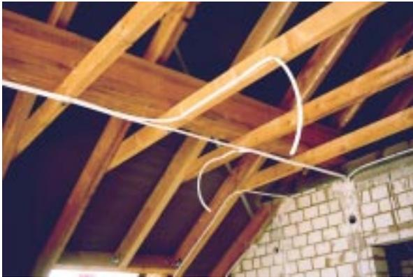
**Bild 6.5- 6:** Strom-Hüllrohre an Sparren genagelt behindern spätere Verlegung der Folie.
