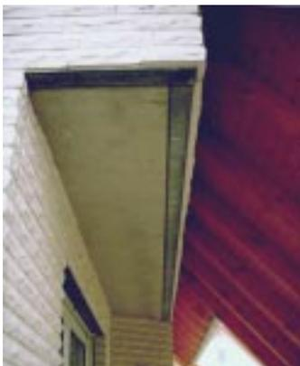
**Bild 5.4- 16:** Starke Wärmebrücken an auskragender unterseitig ungedämmter Decke mit Klinkerauflager aus Stahl.
