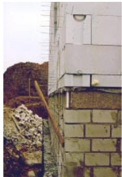
**Bild 4.4- 18:** Zu kleiner Kellermauvorsprung für 15 cm Dämmung und Klinker.
