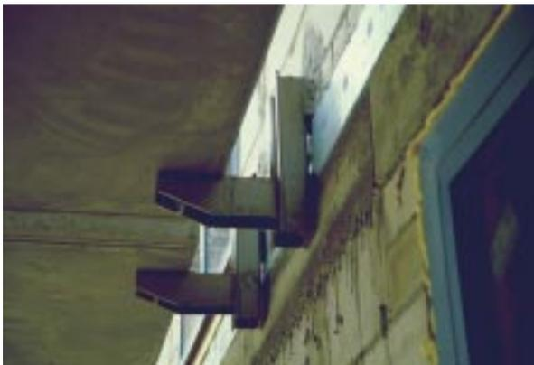
**Bild 5.4- 6:** Fertiggeländer mit nur punktueller Auflager, dessen meiste Oberfläche später unter dem Wärmedämmverbundsystem eingeschäumt wurde.
