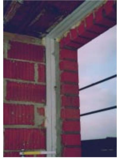
**Bild 5.5- 4:** Fenstermauernase mit verringerter Wärmebrücke durch 2 cm Hartschaum-Überdämmung.
