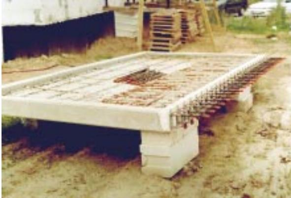
**Bild 5.4- 4:** Fertiggeländer mit an der gesamten Längskante werksseitig angebrachtem Isokorb. Die vielen Edelstahl-Streben stellen auch Wärmebrücken dar.
