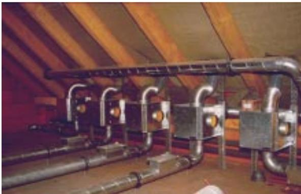
**Bild 8.2- 19:** Wohnungsweise Abluftventilatoren in einem MFH auf dem Spitzboden.
