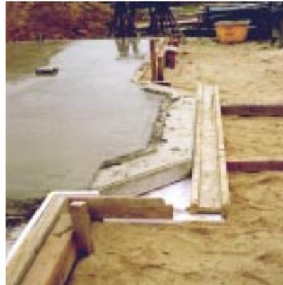
**Bild 5.4- 13:** Thermisch getrenntes Klinkerauflager am Erker mit Isokorb-Randstreifen.
