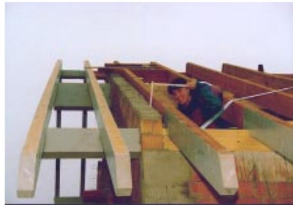
**Bild 5.7- 3:** Giebelmauer endet ca 8 cm unter Sparrenoberkante, Sparren liegt mit hinreichendem Abstand zur Innenmauerschale.
