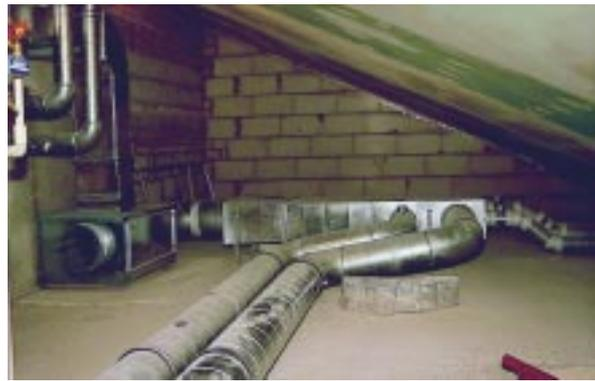
**Bild 8.2- 20:** Gemeinsamer Abluftventilator für ein MFH auf dem Dachboden.
