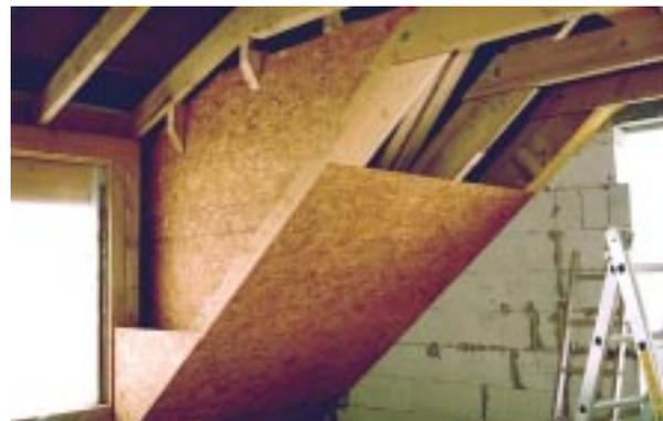
**Bild 6.3- 2:** Luftdichtung durch OSB-Spanplatten mit Nut-und-Feder-Verbindung.
