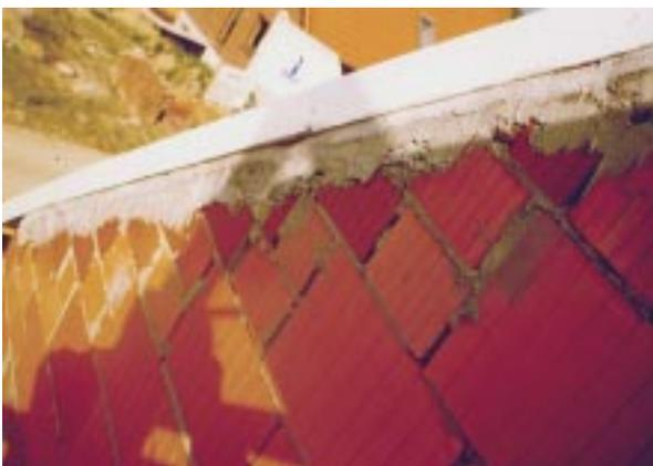
**Bild 5.7- 4:** Oberkante der Giebelmauer mit 8 cm Polystyrol-Dämmplatten im Mörtelbett belegt.
