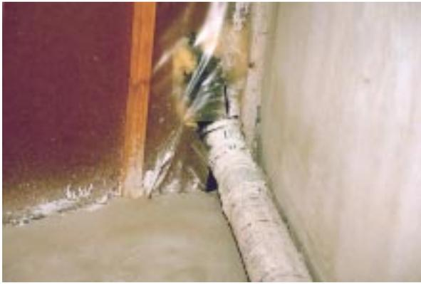
**Bild 6.5- 12:** Zu stark in die Ecke gequetschtes Fallrohr lässt sich nicht an die Folie andichten.
