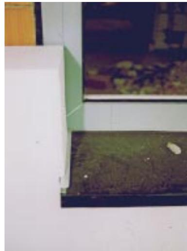
**Bild 5.5- 9:** Keine Wärmebrücke durch Überdeckung des Blendrahmens mit Außendämmung.
