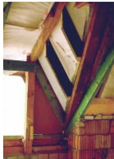
**Bild 4.12- 5:** Schwieriges konstruktives Gerüst einer Trapezgaube. Verschiedene Balkenstärken und Holzanteile in den einzelnen Ebenen erschweren die Planung.
