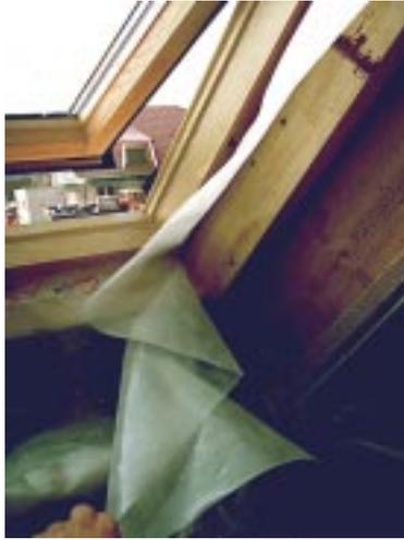
**Bild 4.13- 7:** Dachflächenfenster mit falschen Verbindungsmitteln der Luftdichtungsebene: das Folienklebeband hält nicht auf Holz.
