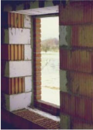
**Bild 5.5- 2:** Fenstermauernase mit verringerter Wärmebrücke durch Porenbeton-Stein.
