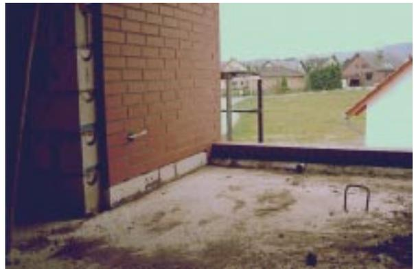
**Bild 5.4- 15:** Thermisch getrenntes Klinkerauflager auf Loggia-Decke.
