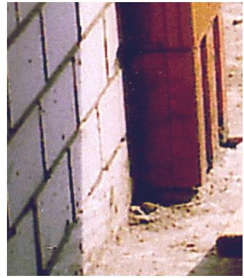
**Bild 4.5- 13:** Mauerwerksanschlag für die Eingangstür eines MFH. Der Mauervorsprung deckt nur knapp die Dämmung der Treppenhaustrennwand ab.
