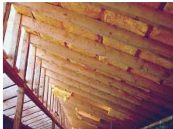
**Bild 4.9- 12:** Dachstuhl mit oberseitiger Queraufdoppelung und dazwischen von oben ausgerollter Mineralwolle-Dämmung. Die Zwischensparrendämmung wurde nachher von unten eingebaut.
