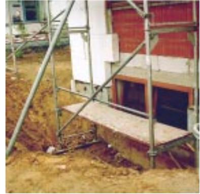
**Bild 4.3- 10:** fehlende Dämmung der Beton-Außenwand eines in den Gebäudeplanungen nicht deklarierten beheizten Arbeitsraumes im Keller. Dieses Objekt war in der Ausführungsphase nicht betreut.
