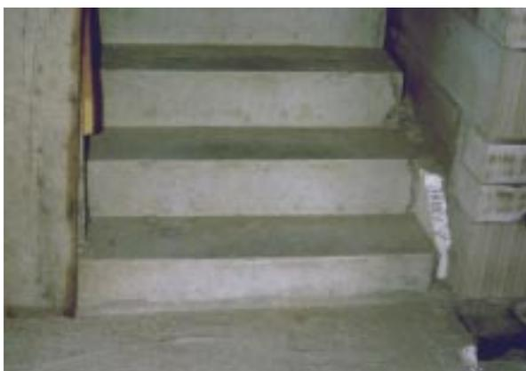
**Bild 4.6- 5:** Vermiedene Wärmebrücke an einer "warmen" Kellertreppe zu einer angrenzenden "kalten" Kellerwand durch seitlichen 8 cm starken Dämmstoffstreifen.
