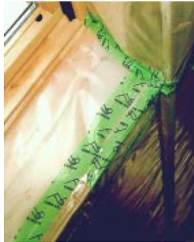
**Bild 4.13- 11:** Dachflächenfenster von (Bild 4.13-10) nach dem Verbinden der Folienschürze mit der Luftdichtungsfolie des sonstigen Schrägdaches. Der Anschluß konnte luftdicht und dennoch zügig hergestellt werden.
