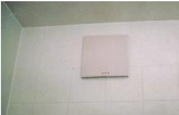
**Bild 8.2- 13:** Für Wohnungslüftung unterdimensionierter einziger Abluftventilator.
