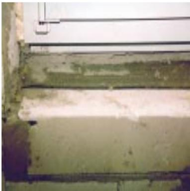
**Bild 6.4- 12:** Luftdichtung durch eingeputzte Folie zwischen Fenster-Blendrahmen und Brüstungsmauer.
