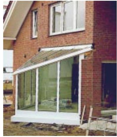
**Bild 4.8- 7:** Glaserker mit Metallrahmen der Rahmengruppe 2 statt geplanter Rahmengruppe 1 erhöht den Wärmeleistungsbedarf des gesamten NEH um ca. zwei Prozent.
