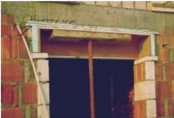
**Bild 5.5- 14:** Selbstgebaute allseitige Zusatzdämmung eines Rolladenkastens.
