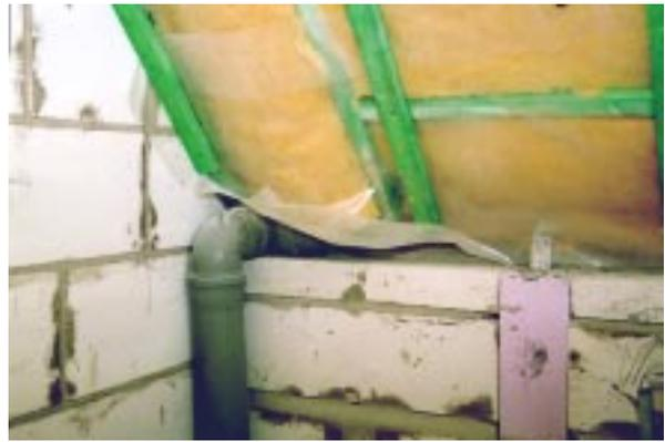
**Bild 6.5- 13:** Ebenfalls aus Platzmangel ungelöste Abdichtung zwischen Rohrleitung und Folienebene. Rohrverlegung in Außenecke des Raumes behindert auch den luftdichtenden Innenputz.
