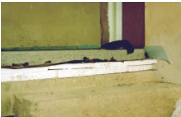
**Bild 4.2- 6:** Ungenügende Dämmung der Kellerdecke von nur 7,5 cm statt geplanter 12 cm.
