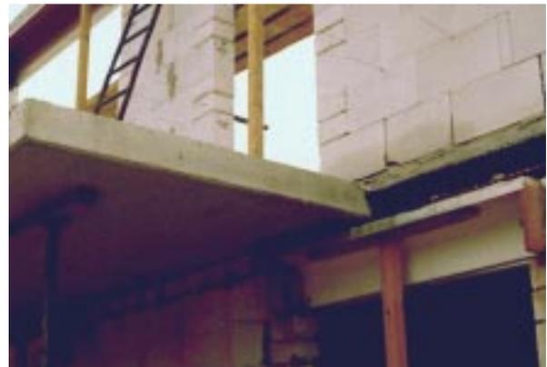
**Bild 5.4- 7:** Wärmebrücke zwischen Balkon und Stahlsturz über einem Fenster.
