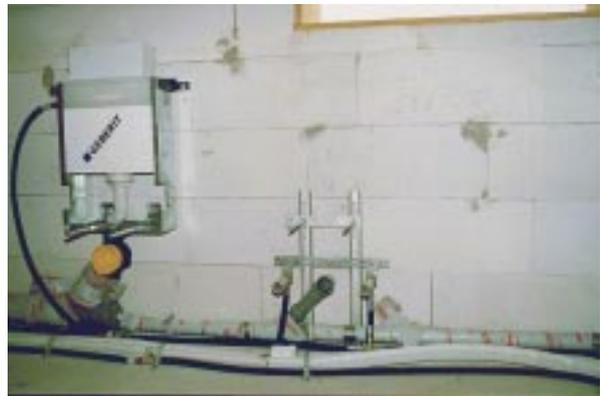
**Bild 6.2- 4:** Vorwandinstallationen an einer unverputzten luftundichten Außenwand. Nach Bemängelung wurden die Installationen wieder abgebaut und die Wand vorab verputzt.
