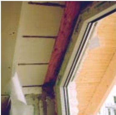
**Bild 6.4- 9:** Unklare luftdichtende Anschlußmöglichkeit bei oben miten in der Dämmschicht endendem Fensterrahmen.
