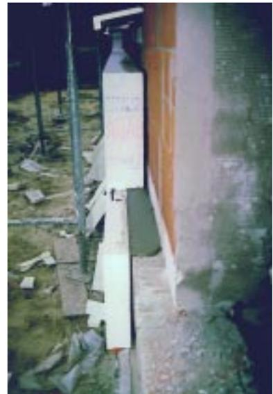
**Bild 5.2- 18:** Abgestufte Dämmung der EG-AW und KE-AW auf abgetrepter Kellermauerkrone.
