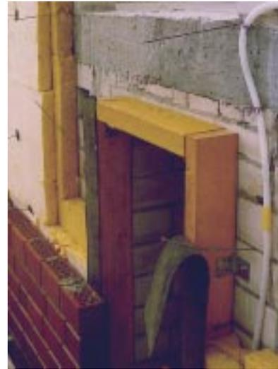
**Bild 5.5- 7:** Schalenüberbrückung mit geringer Wärmebrücke aus Kantholz-Rahmen.
