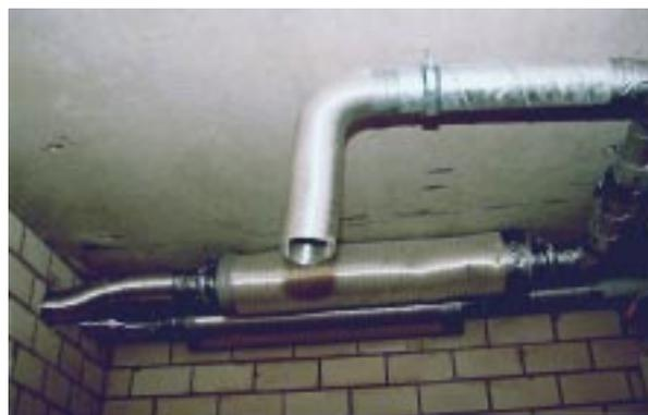
**Bild 8.2- 24:** Unnötige Rohrlängen und -kosten durch unüberlegte Verlegung.
