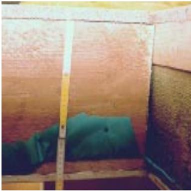
**Bild 6.4- 15:** Undefiniertes und nicht mehr anschließbares Ende der luftdichtenden Folie im Bereich einer Bodenluke.
