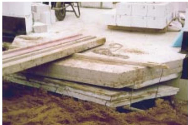
**Bild 4.1-9:** Wegen mangelnder Haftung und Beschädigung wieder abgerissene unterseitige Dämmung einer auskragenden, später erdberührenden Erkerbodenplatte.
