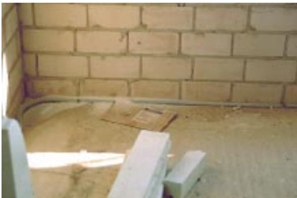
**Bild 6.2- 5:** Elektro-Hüllrohr direkt an Außenwand verlegt behindert vollflächiges Verputzen der Wand bis zur Rohdecke herab.
