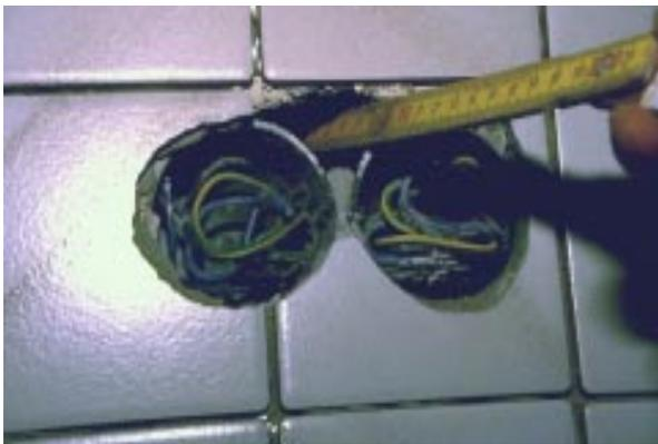
**Bild 6.5- 8:** Steckdose in Hohlsteinwand mit starker Luftundichtheit..
