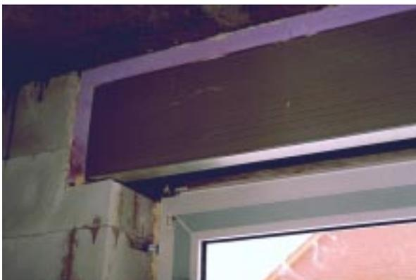
**Bild 5.5- 16:** Seitliche und obere Zusatzdämmung eines nur innenseitig serienmäßig ausreichend gedämmten Rolladenkastens
