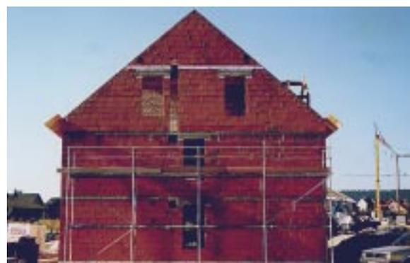
**Bild 5.6- 6:** Giebelwand des unbeheizten Spitzbodens mit Porenbetonstreifen in der Ebene der Kehlbalkendecke von OG-Außenwand abgetrennt.
