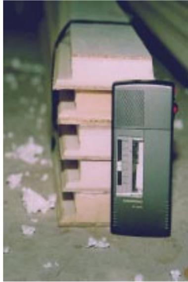
**Bild 5.5- 18:** Gut wärmegeämmte untere Revisionsdeckel von Rolladenkästen.
