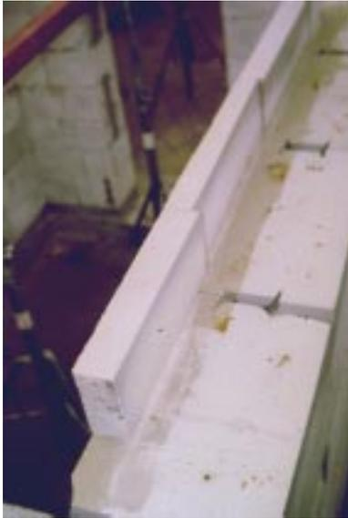
**Bild 5.2- 13:** Randaufmauerung aus Porenbeton als thermisch trennende Seitenschalung der kalten Kellerdecke im warmen Treppenhaus.
