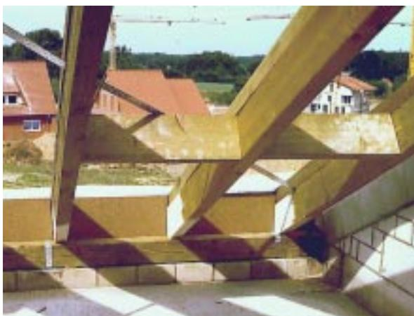
**Bild 4.9- 11:** Dachstuhl mit oberseitiger Längsaufdoppelung der Sparren. Der Zwischenraum wurde in einer Schichtlage mit Zelluloseflocken gedämmt.
