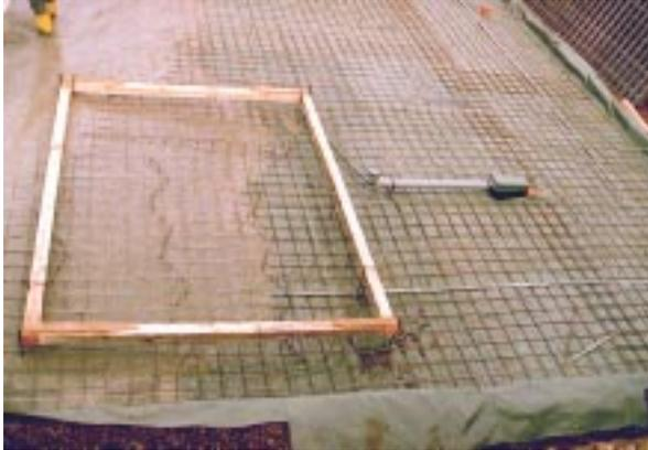
**Bild 4.1-6:** Holzrahmen auf Sohlplattenarmierung als Begrenzung des abgesenkten Sohlplattenbereichs unter künftigem beheiztem Treppenhaus. In dem abgesenkten Bereich kann die verstärkte Unterestrichdämmung eingelegt werden.
