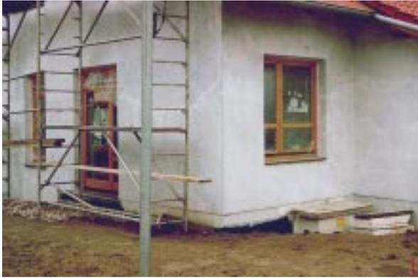
**Bild 4.4- 14:** Optische Ansicht Südostfassade mit versteckten Mängeln am PS-Thermohautsockel.
