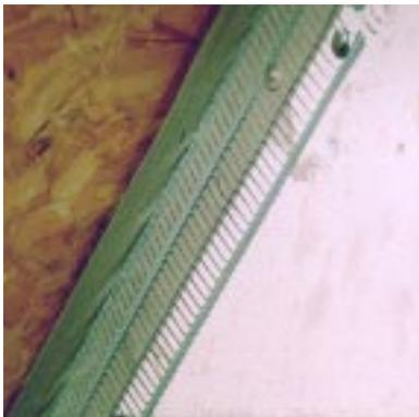
**Bild 6.3- 6:** Luftdichtung zwischen Leichtbau und Putz durch auf die Gipsbrettplatte aufgeklebten Baupappestreifen, der an der Wand unter Streckmetall eingeputzt wird.
