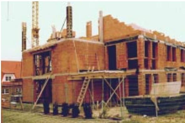
**Bild 5.4- 14:** Loggiabau mit ungeklärten Wärmebrücken an Übergängen zwischen Decken, zweischaigen Wänden und Betonstützen.
