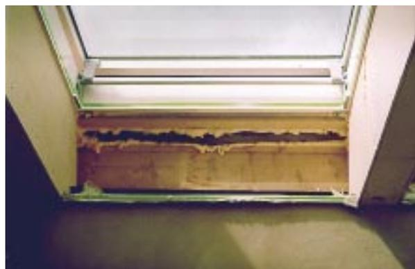
**Bild 4.13- 5:** Bekleidung der seitlichen Laibungen trotz komplett fehlender Luftdichtung fertiggestellt.
