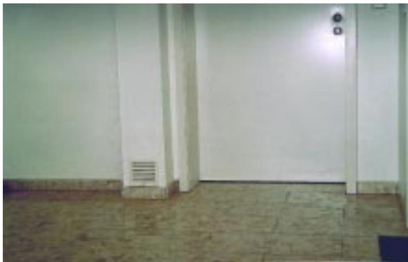
**Bild 8.2- 29:** Warmluft-Beheizung eines MFH-Treppenhauses aus zentral rückgewonnener Wärme der Wohnungsabluftanlagen.
