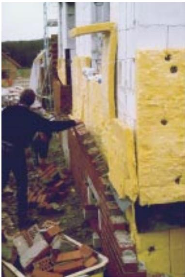
**Bild 4.4- 16:** Klinker muß abgerissen werden wegen ungenügender Dämmung.
