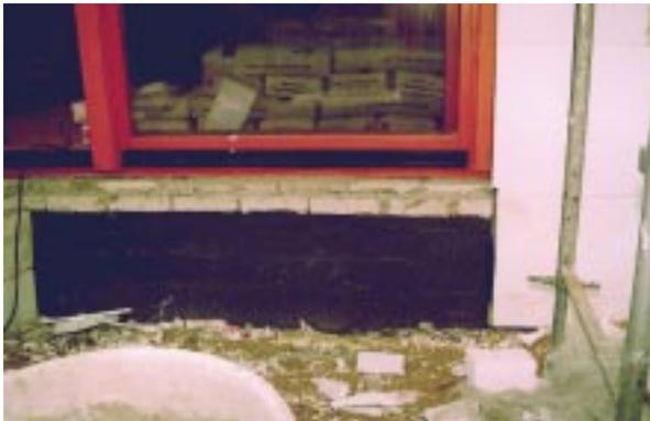
**Bild 5.5- 12:** Starke Wärmebrücke an der Unterfangung der Terrassentür durch ungedämmte 11,5er Steinreihe aus KS (Außenansicht).
