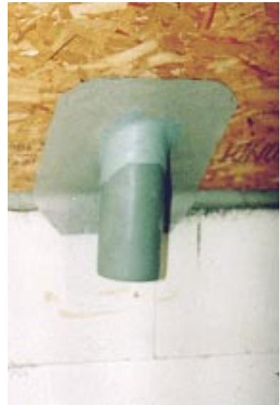
**Bild 6.5- 16:** Abdichtungs-Manchette einer Abluftleitung nach der Verklebung auf der Spanplatte.
