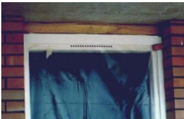
**Bild 8.2- 5:** Lochreihe im Fenster-Blendrahmen als Vorbereitung für Zuluft-Spaltventil.
