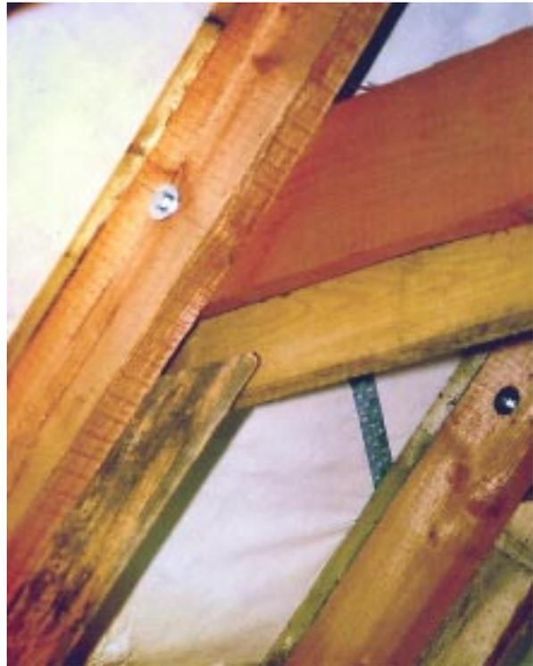
**Bild 4.10- 8:** Kehlbalkendecke mit seitlich an die Balken geschraubten Brettern für eine unterseitige Aufdoppelung der Dämmung mit minimalen Holzanteilen.
