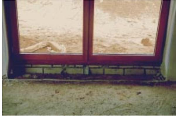
**Bild 5.5- 11:** Starke Wärmebrücke an der Unterfangung der Terrassentür durch ungedämmte 11,5er Steinreihe aus KS (Innenansicht).
