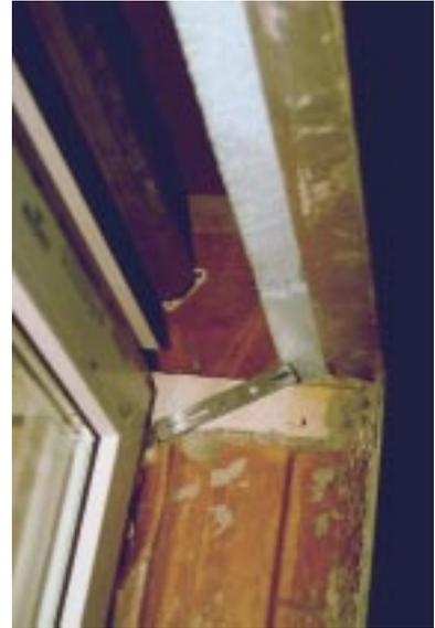
**Bild 5.5- 19:** Wenig wärmeleitender Porenbeton-Auflagerstein und ordentliche innere Dämmung eines Rolladenkastens.
