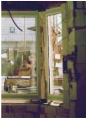
**Bild 6.4- 10:** Unklare luftdichte Verbindungsmöglichkeiten bei Eigenbau-Erkerfenster ohne Eckpfosten im Rohbau.
