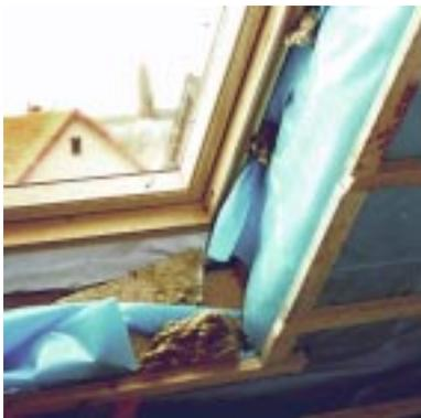
**Bild 6.4- 18:** Mangelhaft verarbeiteter Folienanschluß an einem Dachflächenfenster.
