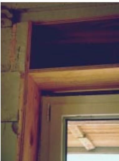
**Bild 5.5- 8:** Schalenüberbrückung mit geringer Wärmebrücke durch Schichtholz-Zarge.
