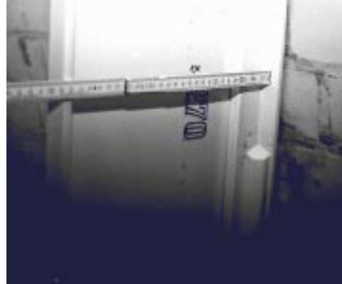
**Bild 4.5- 12:** eine von 20 falschen Türzargen für Trennwand zw. Treppenhaus u. Wohnung im MFH. Zarge mußte ausgetauscht werden, da sie nur die 24 cm KS-Wand und nicht die 10 cm Dämmung umfaßt.
