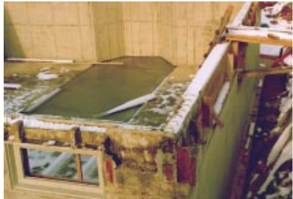
**Bild 4.1-7:** Abgesenkte Sohlplatte (z.Zt. Eisbahn) unter künftigem beheiztem Treppenhaus zur Aufnahme einer höheren Wärmedämmschicht bei gleicher oberer Aufbauhöhe in beheizten und unbeheizten Kellerräumen.
