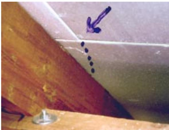
**Bild 4.9- 9** Aufsparrendämmung aus Polystyrol noch ohne Dacheindeckung. Durch die Fugen dringt Wasser ein, die Unterdachfunktion wird trotz Stufenfalzprofil nicht erfüllt.
