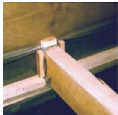
**Bild 6.3- 11:** Abdichtung eines durchdringenden Balkens mit vorkomprimiertem Dichtband und Anpreßleisten.
