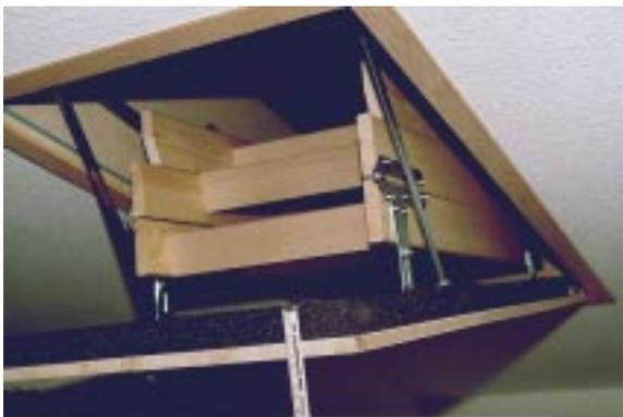
**Bild 4.14- 8:** Bodenluke mit werkseitig angebrachten ca. 4 cm Weichschaumdämmung und k-Wet um 0,8 W/m<sup>2</sup>K.
