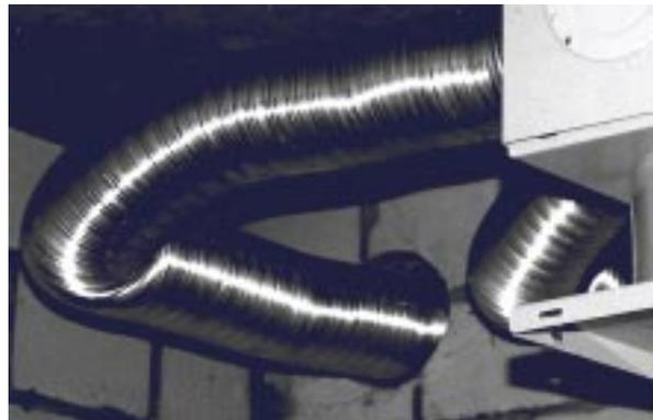
**Bild 8.2- 22:** Strömungstechnisch nachteilige "Aluflex"-Leitung mit starkem Knick
