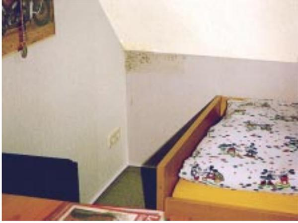
**Bild 4.9- 16:** Schimmel wegen Kondenswasserbildung an fehlerhaftem Detail. Ursache ist ein fehlerhafter Anschluß von Außenwanddämmung zu Dachdämmung im Bereich der Fußpfette an der Drepelmauer, verbunden mit Luftundichtigkeiten an der von innen nach außen durchdringenden Fußpfette.
