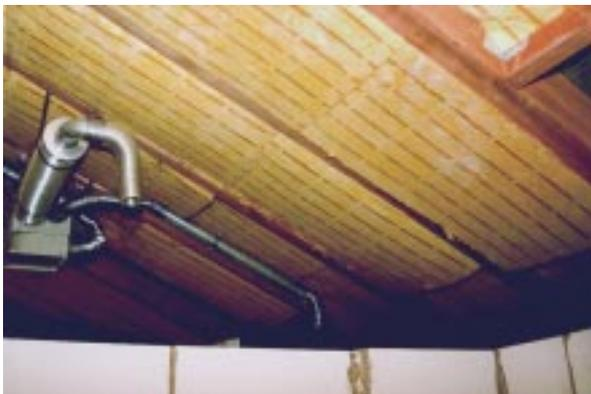
**Bild 6.5- 17:** Einbau der Lüftungsanlage vor der luftdichtenden Folie erschwert deren spätere Montage stark.
