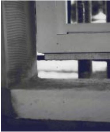
**Bild 4.8- 5:** Dieses Fenster wurde zu klein geliefert. Die u.a. durch geputzte Laibungen und Brüstungen gut vorbereitete Luftdichtheit konnte nicht wie geplant realisiert werden.
