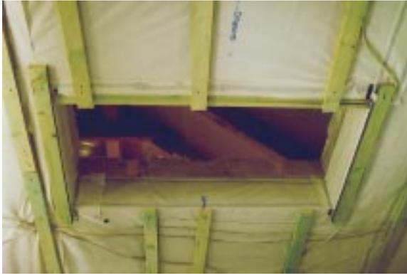
**Bild 4.14- 2:** Luftdichtungsfolie im Deckenausschnitt nicht über Aufdoppelungsebene gezogen.
