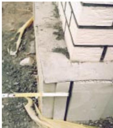
**Bild 4.3- 6:** außenseitige Dämmung der thermisch trennenden Kelleraußenwand bei zweischaliger Bauweise.
