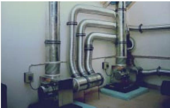
**Bild 8.2- 15:** Zwei separate Abluftventilatoren in einem Zweifamilienhaus mit Aluflex-Verrohrung.
