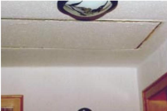
**Bild 4.14- 4:** Optisches Foto einer Bodenluke ohne Zusatzdämmung und -dichtung. Provisorische Luftdichtung während der Dichtemessung mit Fensterkitt.
