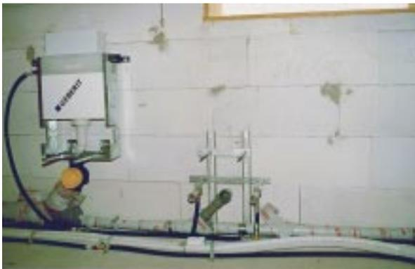
**Bild 6.5- 10:** Vorwandinstallation auf unverputzter Außenwand ergibt starke Luftundichtheit.
