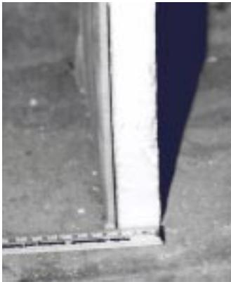
**Bild 4.5- 11:** Trennwand zw. Treppenhaus und Wohnung im MFH aus PS-GK-Verbundplatte, unzureichende Dämmung und schwierige Montage.
