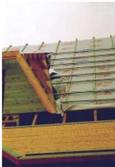
**Bild 4.12- 4:** Unterdachfolie ohne Anschluß an das Gaubendach. Korrekte Verbindung beider Dachteile durch bereits montierte Lattung zusätzlich erschwert.
