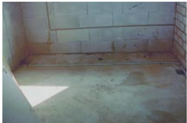
**Bild 6.2- 6:** Elektro-Hüllrohr mit Abstand zur Außenwand verlegt ermöglicht vollflächiges Verputzen der Wand bis zur Rohdecke herab.
