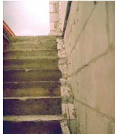
**Bild 5.3- 5:** Bereits vor dem Gießen der Treppe eingelegte Hartschaumplatten zwischen warmem Treppenlauf und später kalter (treppenhausseitig gedämmter) Kellerwand.
