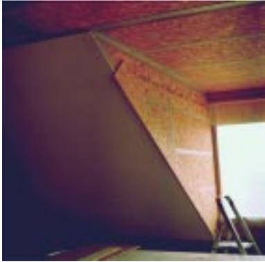
**Bild 6.3- 3:** Luftdichtung durch OSB-Spanplatten und Überkleben der Plattenfugen mit Baupappestreifen.
