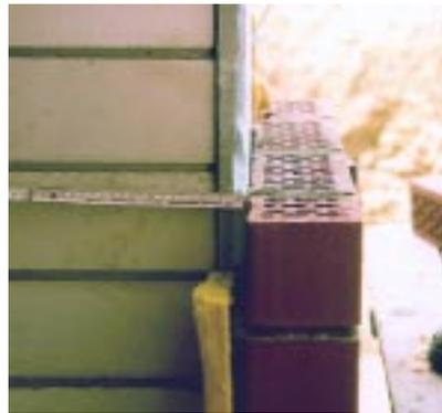
**Bild 4.4- 7:** Unzureichende Wärmedämmung an Außenwand zu Wintergarten.
