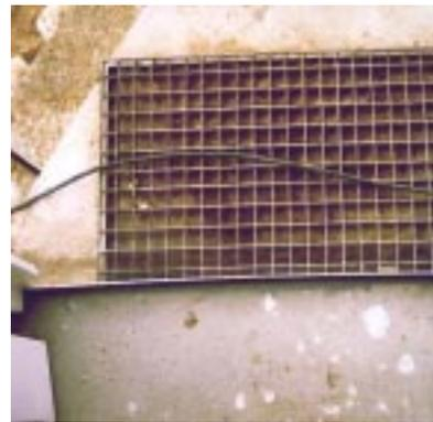
**Bild 6.4- 14:** Luftundichte, weil krumm eingebaute Türschwelle.
