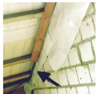
**Bild 6.3- 8:** Fehlerhafter Anschluß zwischen PE-Folie und Mauerwerk. Das Dichtband ist zwischen Folie und Anpreßleiste statt zwischen Folie und Wand eingebaut.
