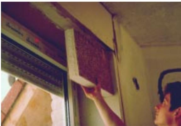
**Bild 5.5- 20:** Stärke einer sehr guten Zusatzdämmung eines einfachen Rolladenkastens.
