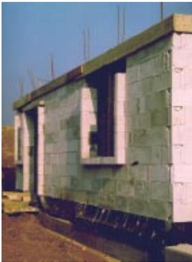
**Bild 5.5- 5:** Fenstermauernase mit verringerter Wärmebrücke durch Porenbeton.
