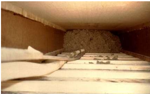
Abbildung 38: Ausblasen des Gefachs mit Mineralwolle
