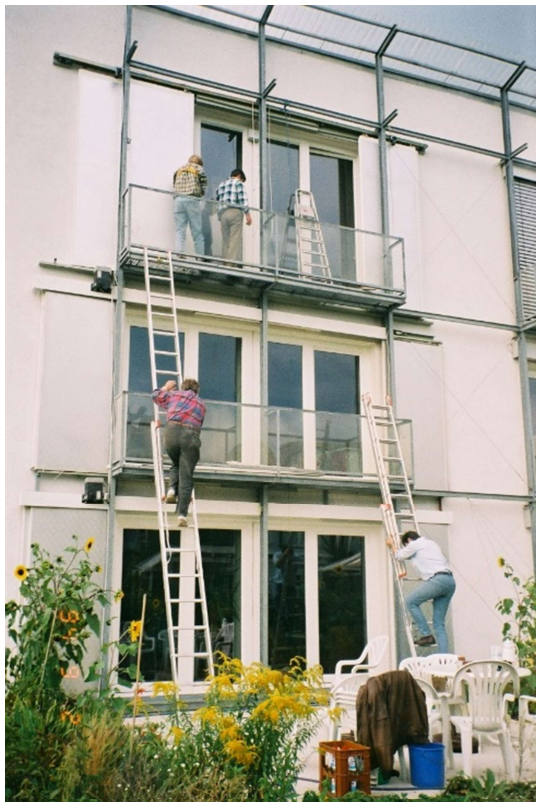
Abbildung 24: Installation der wärmegeämmten Schiebeläden im westlichen Endhaus der Zeile. Die Schiebeläden wurden von K.-H. Fingerling konzipiert (vgl. [Feist 1995b]).
