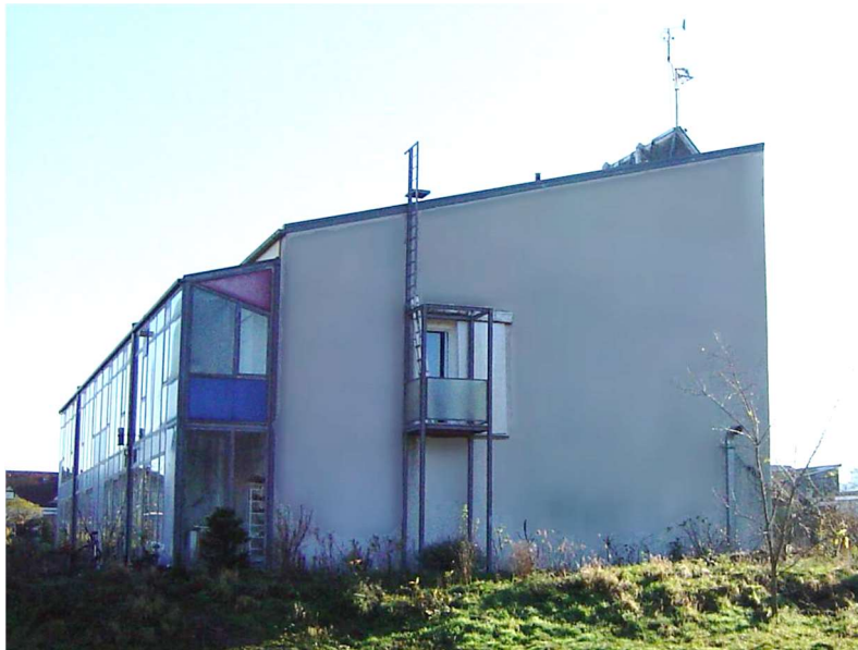
Abbildung 44: Visuelle Aufnahme zur Thermographie der Westwand 1.1.2016
