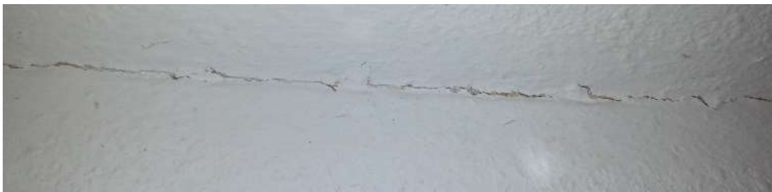
Abbildung 112: Visuelle Aufnahme Tapetenriss an der Anschlussstelle Außenwand/ Dach; Achtung: Das ist nicht die Dichtebene – die liegt darunter in Form der eingeputzten Folie und hält trotz der örtlichen Verschiebung dicht.
