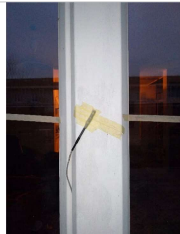
Abbildung 69: Visuelle Aufnahme zur nebenstehenden Thermographie.
