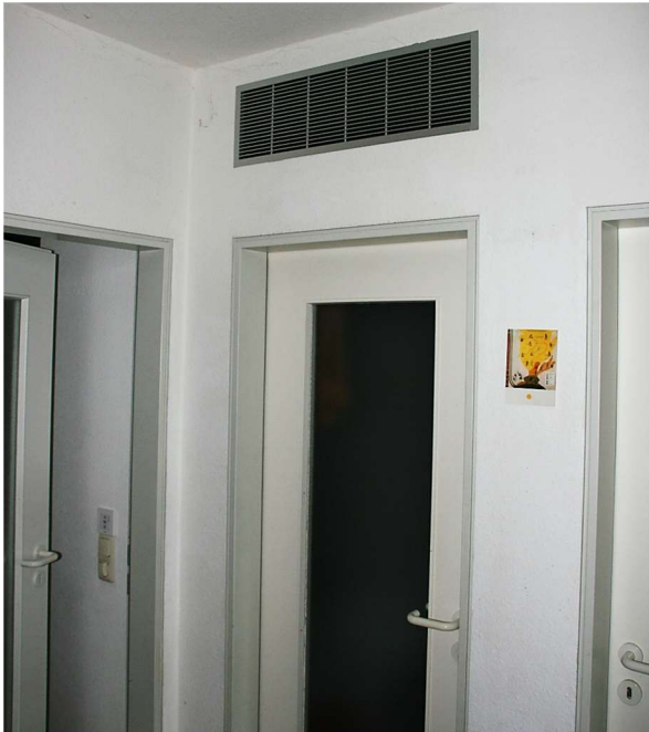
Abbildung 132: Überströmelement oberhalb der Badezimmertür. Für den hier größeren Luftvolumenstrom wurde ein entsprechender Querschnitt vorgesehen. Das Ventil ist im Bad bewusst oben montiert, um Luftströme im Fußbereich zu begrenzen (Komfort im Bad). Der Druckverlust ist außerordentlich gering.
