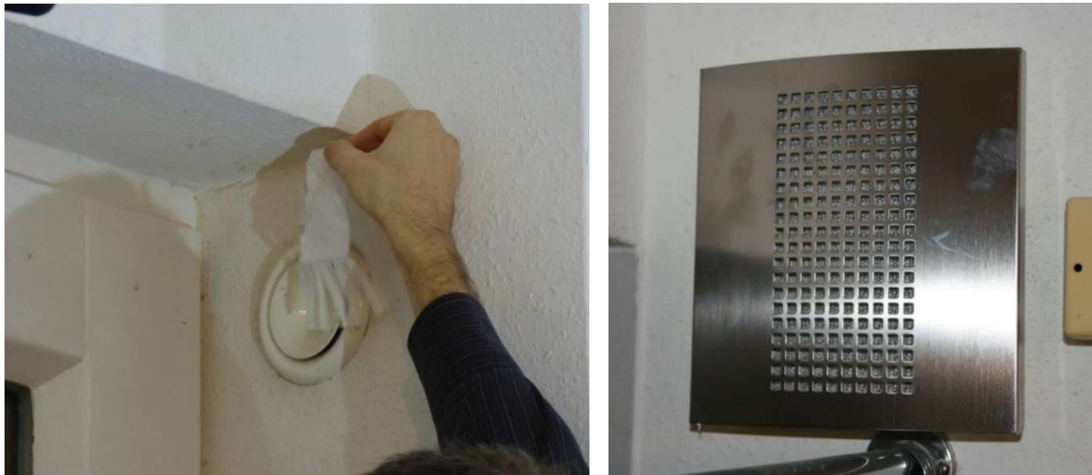
Abbildung 130: links: Zuluftauslass mit Tellerventil im Wohnzimmer/Erdgeschoss des Passivhauses Darmstadt-Kranichstein. Der Luftkanal ist bis an die Außenwand geführt. Heute verfügbare Weitwurf-Ventile erlauben deutlich geringere Kanal-längen durch Anordnung an einer Innenwand.
