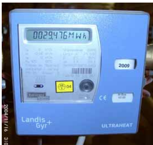
Abbildung 32: Wärmemengenzähler und Teilansicht der hydraulischen Weiche im Technikeller.
