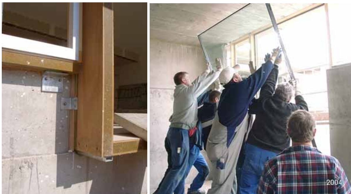
Abbildung 19: Links: Fenstereinbau auf einem Dämmklotz und angrenzend vorgezogener Einbaurahmen für eine Tür zum Hof. Rechts: Einbau einer großen Dreifach-Verglasung.
