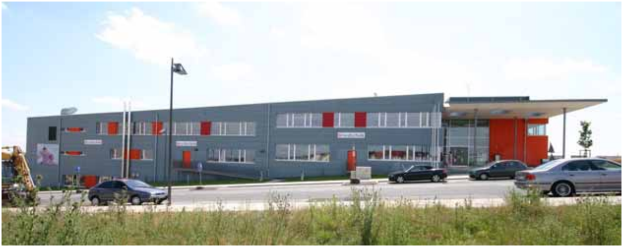
Abbildung 8: Ansicht Nordfassade (ohne Turnhalle)
