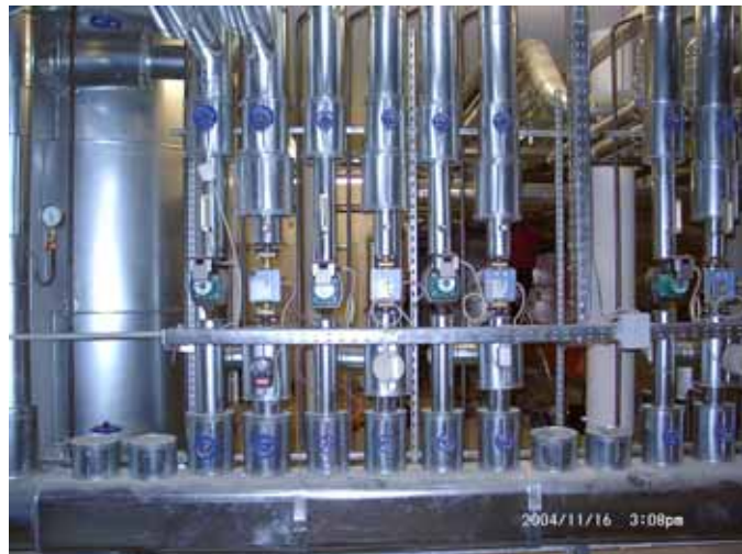
Abbildung 32: Wärmemengenzähler und Teilansicht der hydraulischen Weiche im Technikeller.
