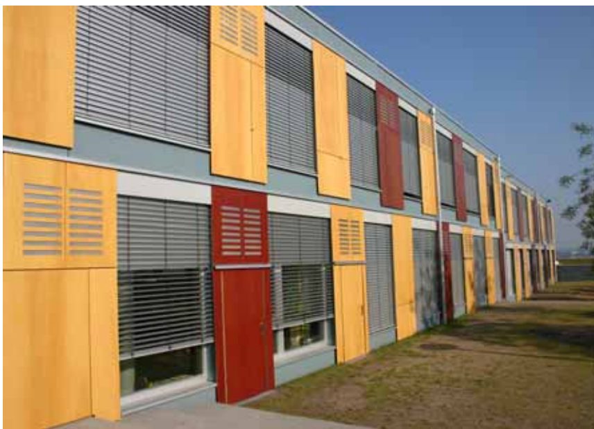
Abbildung 26: Südfassade des Nordflügels mit heruntergelassener Außenverschattung.
