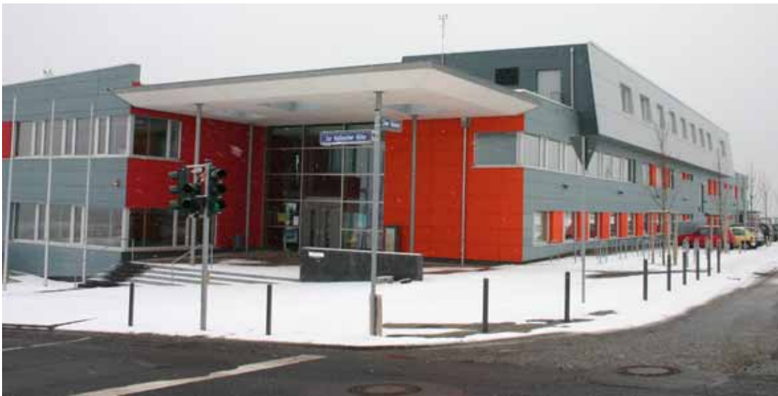
Abbildung 6: Winterliche Ansicht vom Haupteingang (Nord-West).
