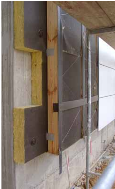
Abbildung 18: Aufbau der vorgehängten Fassade mit zweilagigem Dämmstoff.
