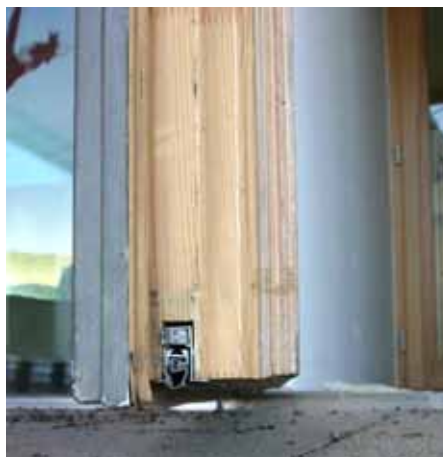
Abbildung 149: Untersuchte Außentür mit Türdichtung und Anschlagdichtung.
