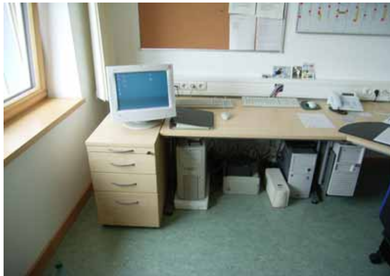
Abbildung 30: Zentraler Messrechner mit Bildschirm und Unterbrechungsfreier Spannungsversorgung (USV) im Büro des Schulhausverwalters (rechts unter dem Tisch: GLT-Rechner und PC des Schulhausverwalters).
