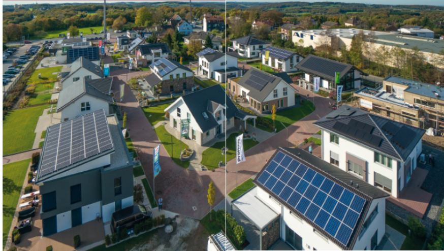
Bild 60: Informationsstehe im Eingangsbereich der FertighausWelt Wuppertal.
