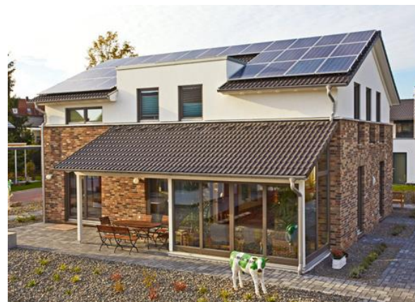
Südost-Ansicht Effizienzhaus Plus Isabella
