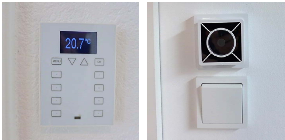
Bild 24: Raumtemperaturerfassung; links mittels Raumthermostaten, rechts durch Nachrüstung von Funksensoren, z.B. über den Lichtschaltern.
