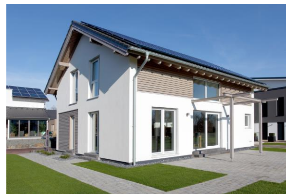
Süd-Ansicht Effizienzhaus Plus
