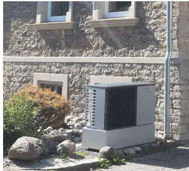
Wärmepumpe am Altbau Effizienz = A-B Sole: 350-450 % Luft: 300-350 %
