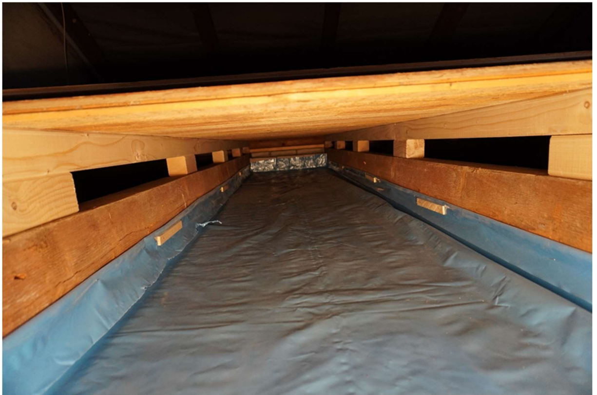
Blick in die Holzbalkendecke vor Einbringung der Dämmung
