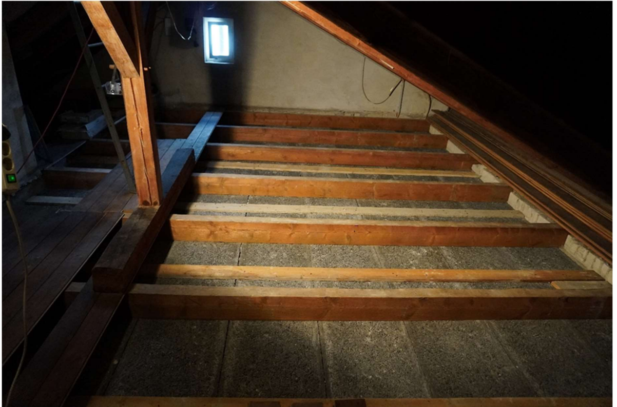
Holzbalkendecke nach Entfernung der alten Isolierung
