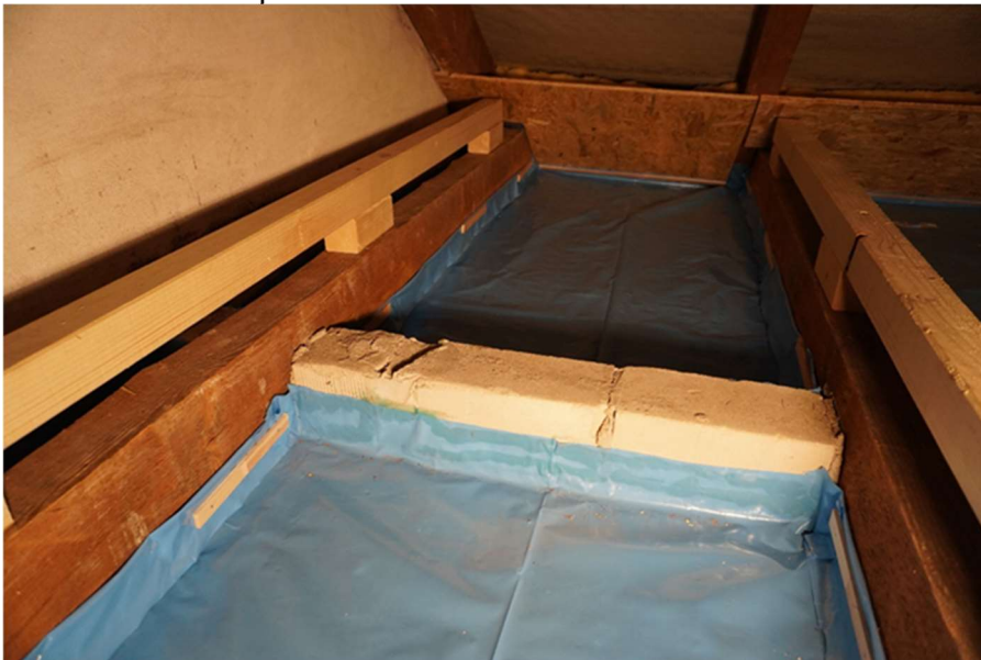
Testbahn mit OSB Platte zur seitlichen Abdichtung des Hohlraums
