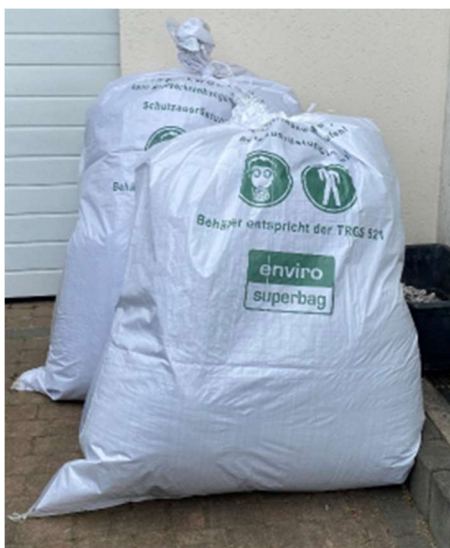
Säcke für die alte Isolierung.
