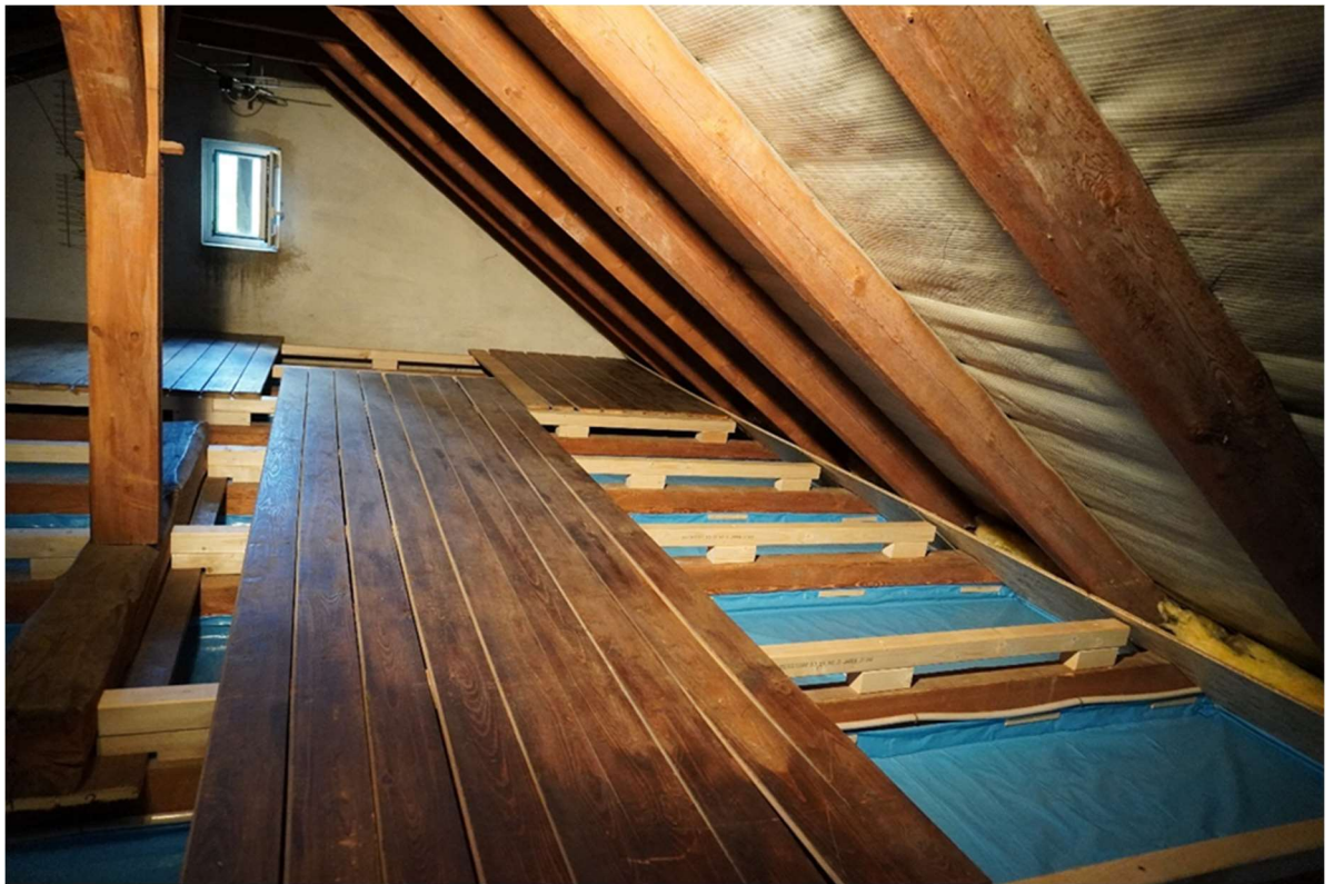
Holzbalkendecke vor dem verschrauben der Dielen
