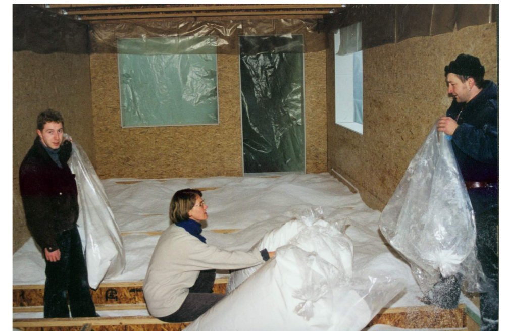
Holzboden im EG mit 35 cm Dämmung aus recyclten PS-Frässpänen
