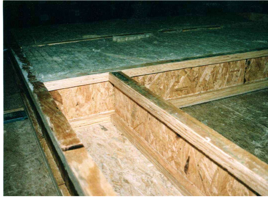
Herstellung der Außenwände mit TJI-Filigranträgern und 24 cm Steinwoll-Dämmung
