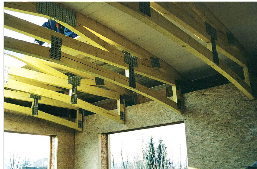
Dachstuhl aus Industrie- Nagelbrettbindern mit Schalung, Blechdach und 45 cm Zellulosedämmung
