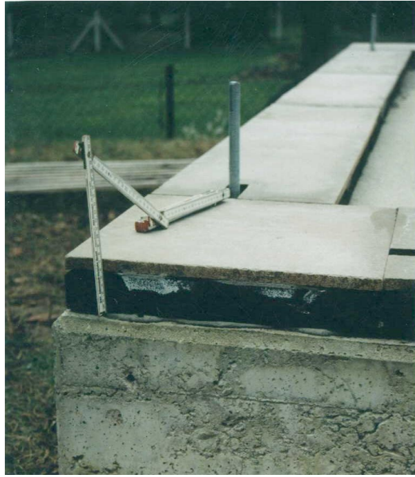
Beton-Bodenplatte Schaumglas unter Schwellholz
