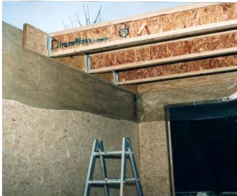
Zwischendecke an Seitenbrett montiert ohne Durchdringung der Wand
