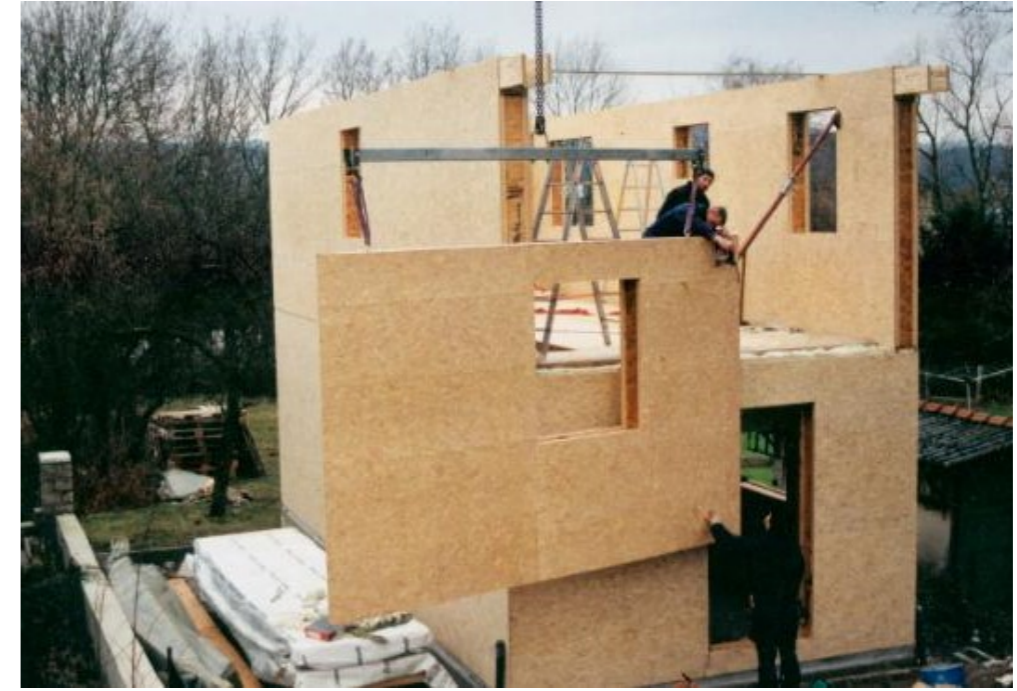
Aufstellung des Hauses an einem Tag incl. Dach am 2.Tag regenfest incl. Fenstern und Türen
