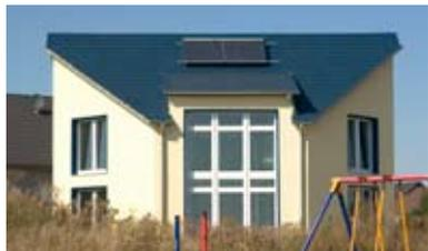
In Koblenz entstand ein individuell geplantes Passivhaus, das im Jahr mit weniger als 1,5 Liter Heizöl pro m<sup>2</sup> umbauten Raum auskommt. Realisiert durch die Kombination von Ytong Porenbeton und Ytong Multipor. Zusätzliche Dämmung der Fassade und Aufbau des Massivdachs mit doppelter Lage Ytong Multipor.
