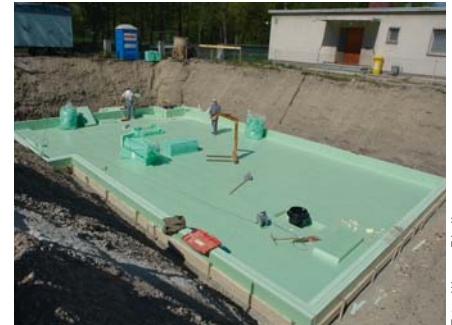
Dämmung unter Bodenplatte
