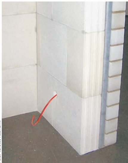
Modell einer zweischaligen Außenwand mit VIP-Dämmung
