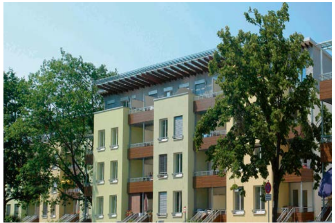
Mehrfamilienhaus (Sanierung 2009) – Passivhaus Aufstockung, 90439 Nürnberg, Außenwand: Kalksandstein mit WDVS, Bauherr: wbg Nürnberg GmbH, Entwurf: Schulze Darup & Partner, Bauüberwachung: Aicher & Hautmann, Nürnberg
