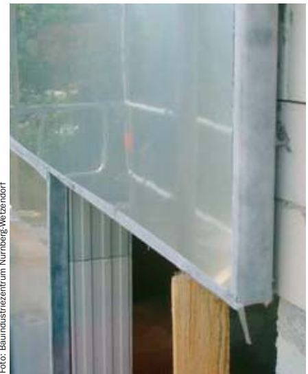
VIP-Dämmung im Bereich der Fenster
