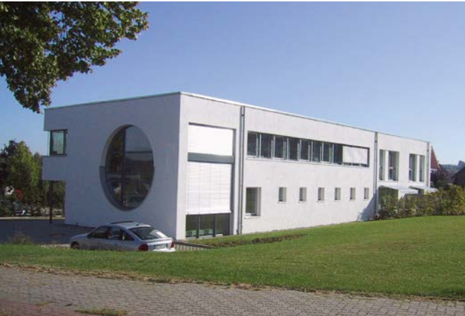
Bürogebäude (2004), 38259 Salzgitter, Außenwand: Kalksandstein mit WDVS Entwurf: architecten gjh Guder – Jung – Hämmerli, 38228 Salzgitter, www.architekten-gjh.de
