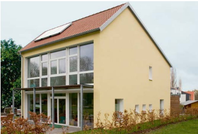
Einfamilienhaus (2009), 44137 Dortmund, Außenwand: Kalksandstein mit WDVS Entwurf: BauWerk Architektengemeinschaft, 44137 Dortmund, www.bauwerk-architekten.de
