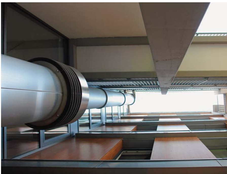
Frischluf- und Fortluftleitung der Lüftungsanlage
