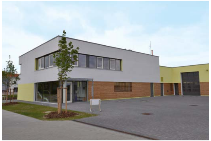
Feuerwehrtechnische Zentrale (2010), 31303 Burgdorf, Außenwand: Kalksandstein mit WDVS Entwurf: Mosaik Architekten, 30167 Hannover, www.mosaik-architekten.de
