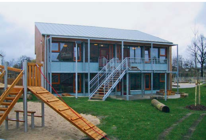
Kita Windröscheweg (2008), 30519 Hannover, Außenwand: Kalksandstein mit Wärmedämmung und hinterlüfteter Holzverschalung, Entwurf: Stadt Hannover, FB Gebäudemangement, 30449 Hannover, Ausführung: Mosaik Architekten BDA, 30167 Hannover, www.mosaik-architekten.de
