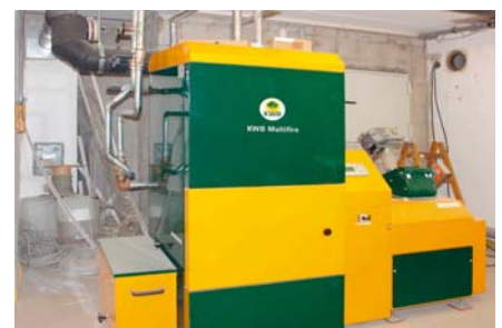
Technikzentrale mit Pelletsessel
