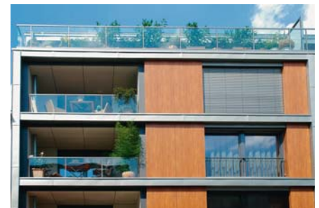
Fassadengeteilte Balkons auf der Südseite
