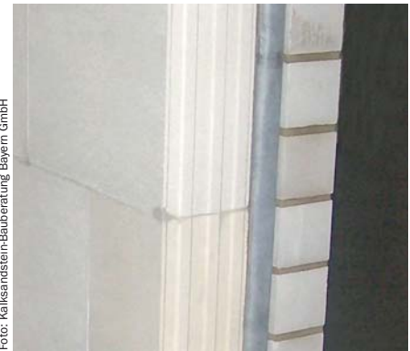
Anschluss Verblendmauerwerk
