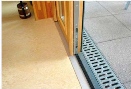
Einbau eines Fensters: barrierearme Schwelle
