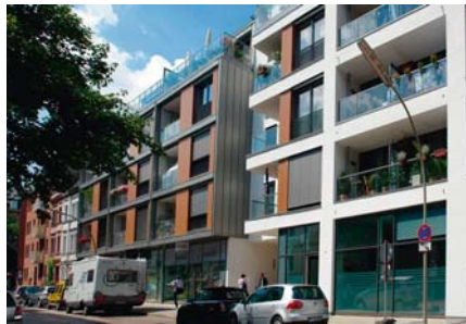
Ansicht Südost aus der Erdmannstraße
