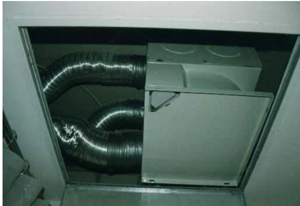
Bild oben: Ventilator eingebaut hinter abgehängter Decke in WC
