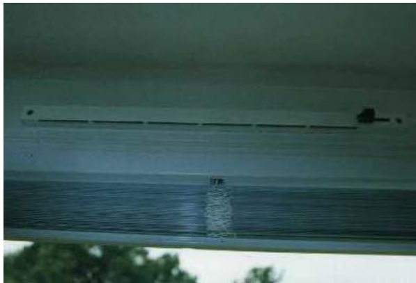
Fresh Spaltventil im Fensterrahmen
