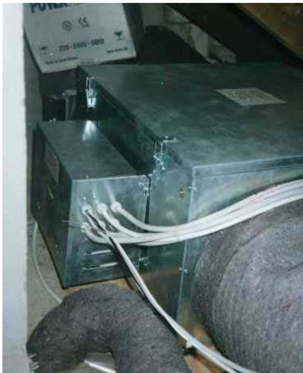
Bild links: Klimabox eingebaut in Technikraum
