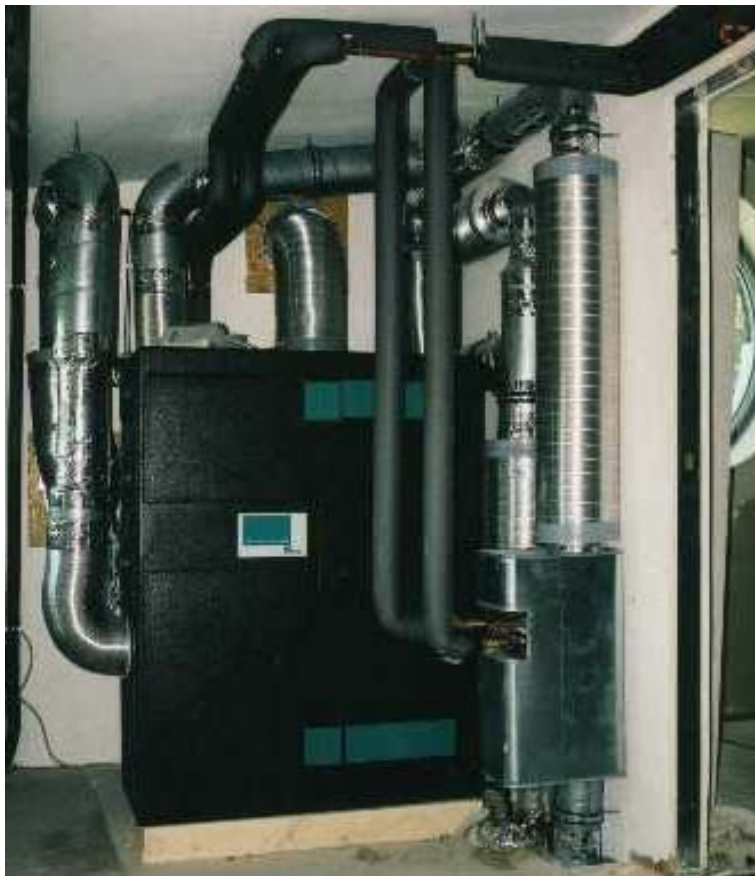
Bild oben: Anlage eingebaut in Technikraum eines Passivhauses
