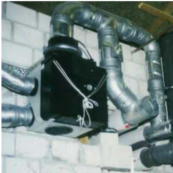
Aereco VEF, wandhängend eingebaut in Objekt 15.
