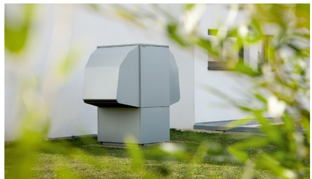
Abb. 5.2 Luft/Wasser-Wärmepumpe in Außenaufstellung
